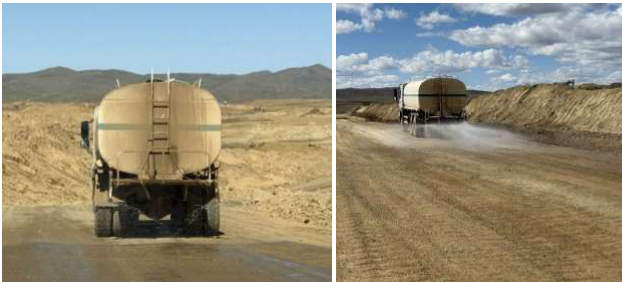
Зураг 5 Усалгааны ажил хийгдэж буй байдал
