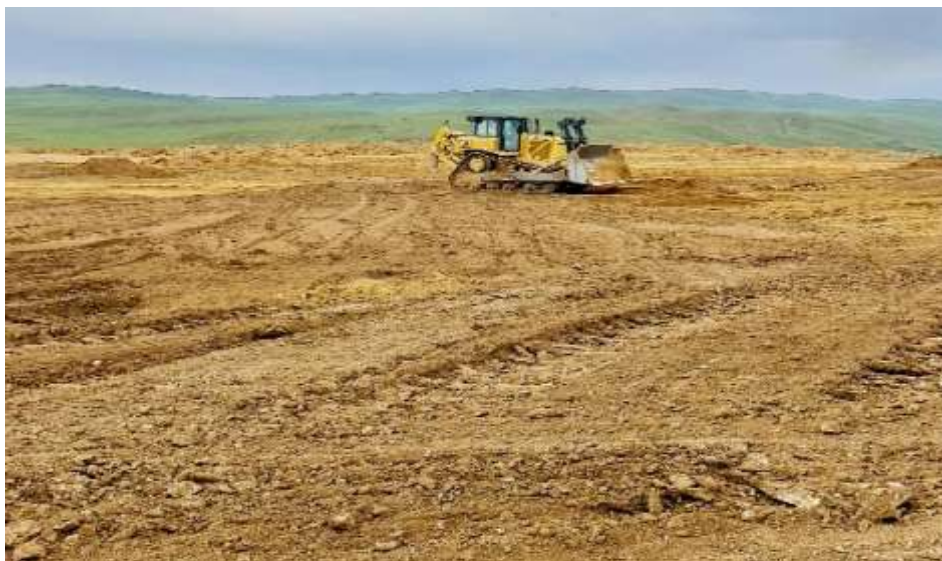
Зураг 20 Шимт хөрсний хучилтын ажил буюу Шимт хөрс дэвссэн байдал
