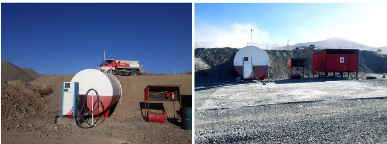
Зураг 4. ШТС-ийн талбай орчмыг бетондсон байдал
