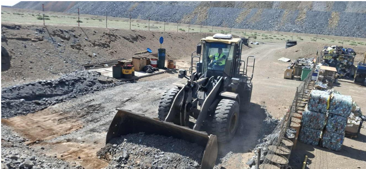
Зураг № 119 Хоол хүнсний хаягдал бордоошуулах талбайн тусгаарлах материал дэвссэн байдал
