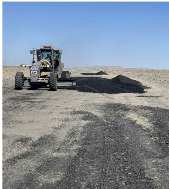
Зураг №1,2 Замын эвдрэл үүссэн хэсгүүдэд дэвсэлтийн материал зөөвөрлөн байршуулсан байдал
