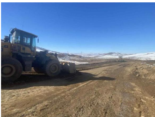
Зураг 9. Автогрейдерээр Уурхайн дотоод зам талбайг хөрс суларсан тохиолдолд суларсан шороог түрж хашлага хийж ажилласан.
