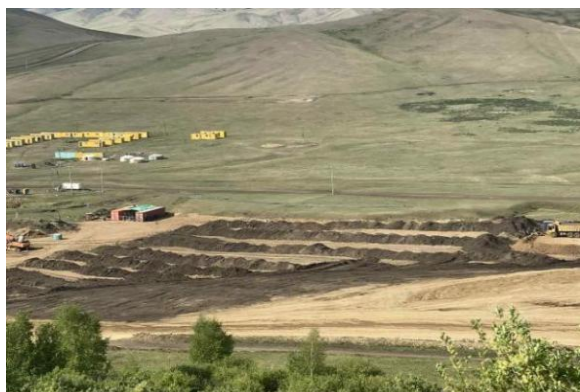
Зураг 8. Техникийн нөхөн сэргээлтийн талбайд шимт хөрсний хучилт дэвсэлтийн ажлууд хийж байгаа байдал.
