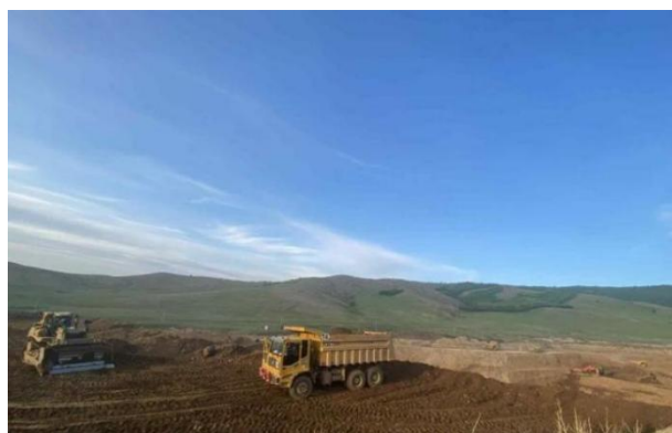
Зураг 8. Техникийн нөхөн сэргээлтийн талбайд шимт хөрсний хучилт дэвсэлтийн ажлууд хийж байгаа байдал.
