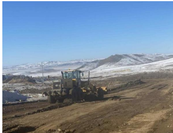
Зураг 9. Автогрейдерээр Уурхайн дотоод зам талбайг хөрс суларсан тохиолдолд суларсан шороог түрж хашлага хийж ажилласан.
