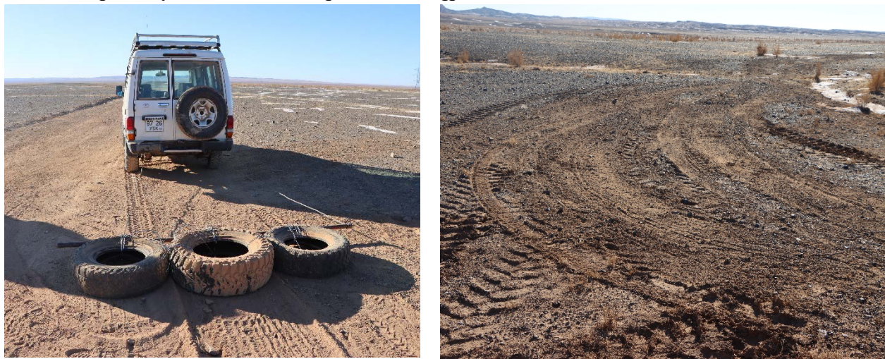
Зураг 23. Вибраторын мөрийг тэгшилж буй байдал
