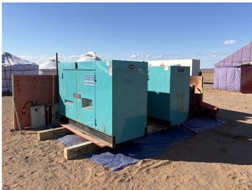
Зураг 20. Генератор болон түлшний машины доор хөрсийг хамгаалах хучилт хийсэн байдал
