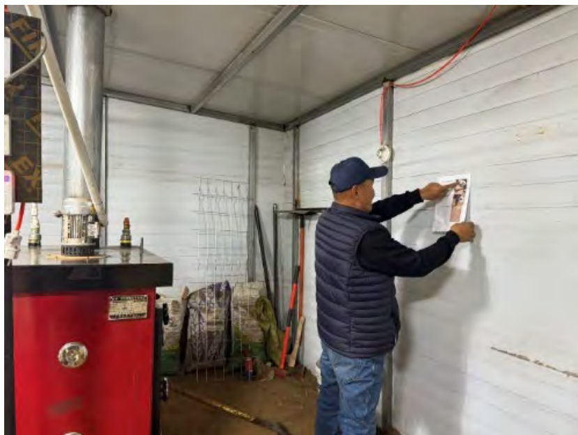
Зураг 14. Уурын зуухны өрөөнд асгаралтын үед авах арга хэмжээний зөвлөмж байрлуулж буй нь
