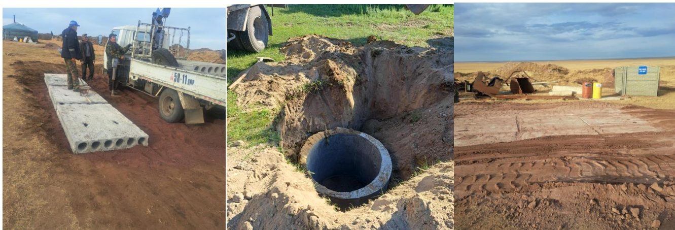
Зураг 10 Засварын талбайг цементлэж 8 бохирын кольцо суулгав.
