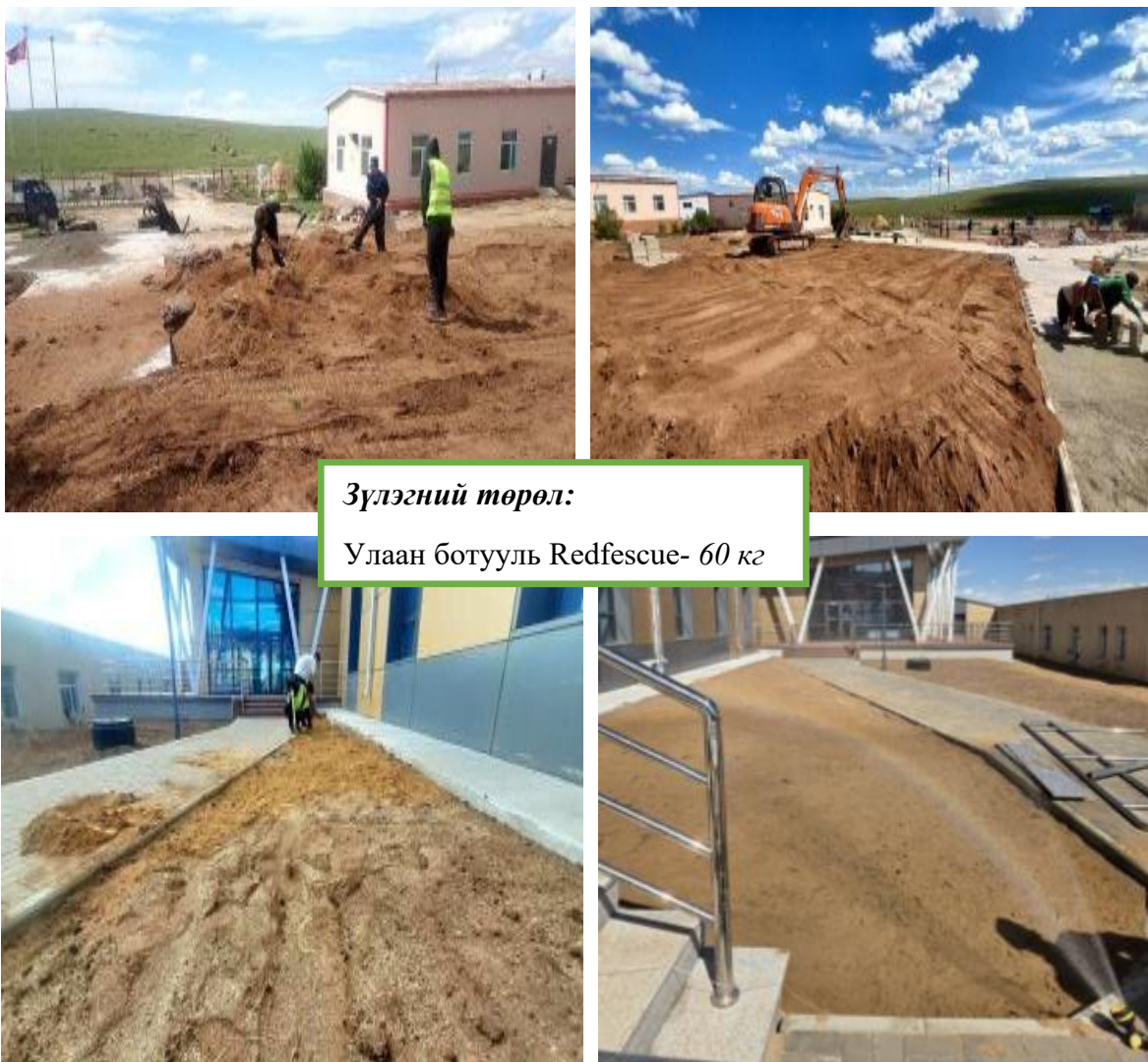
Зураг-7. Кемпийн зүлэгжүүлэлтийн ажил хийгдэж буй байдал
