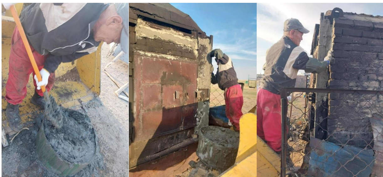
Зураг № 73. Шатаах зууханд засвар үйлчилгээ хийж буй нь
