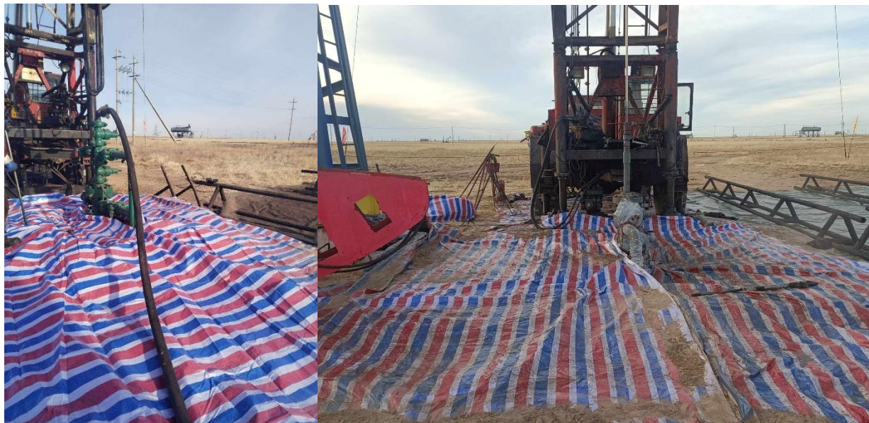
Зураг № 62. Асгарсан тос газрын хөрсөнд шууд нэвчихээс сэргийлж дэвсэсэн дэвсгэр
