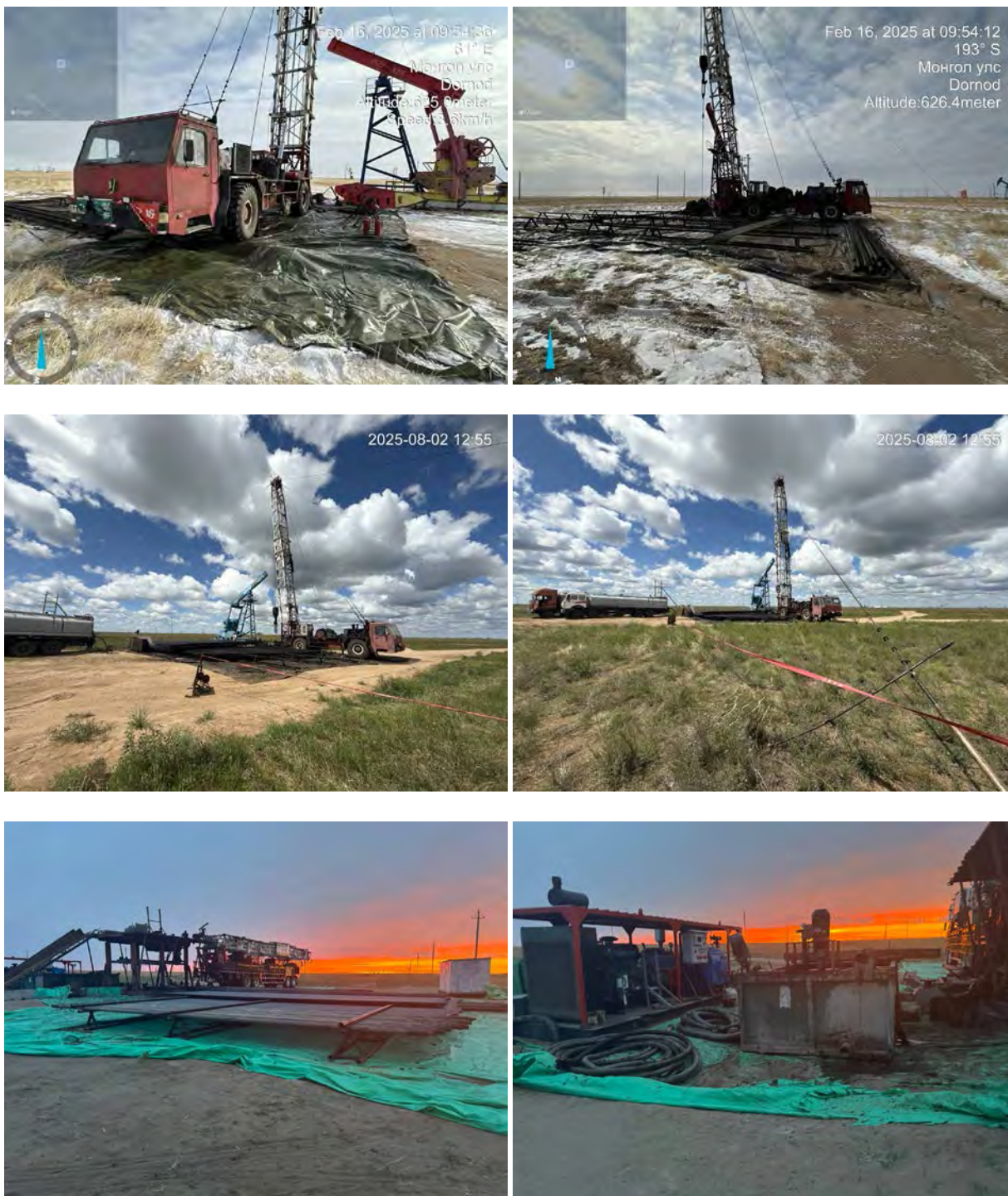
Зураг-15. Хөрсөнд тос үл нэвчихээс хамгаалах дэвсгэр дэвссэн үйл явц
