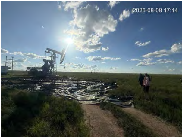
Зураг-16. Хөрсөнд тос үл нэвчихээс хамгаалах дэвсгэр дэвсэх үед орон нутгийн удирдлага хяналт тавьж байдал
