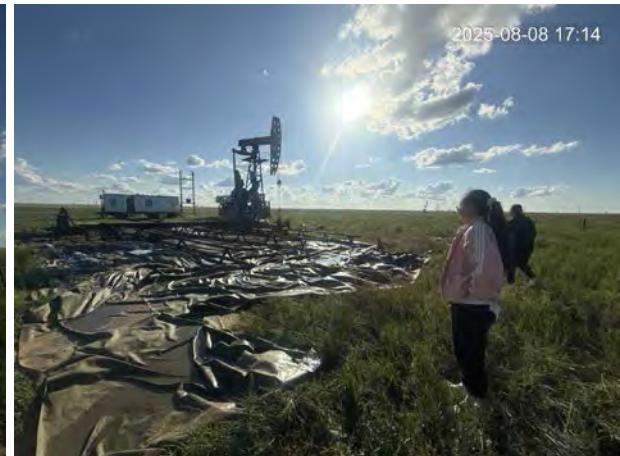
Зураг-16. Хөрсөнд тос үл нэвчихээс хамгаалах дэвсгэр дэвсэх үед орон нутгийн удирдлага хяналт тавьж байдал
