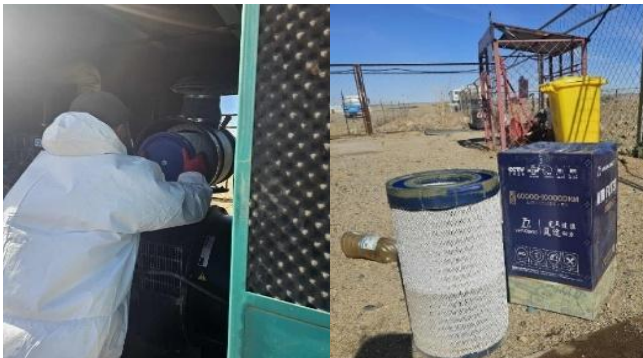
Зураг 17. Дизель генераторт агаар шүүгч суурилуулж байгаа нь
