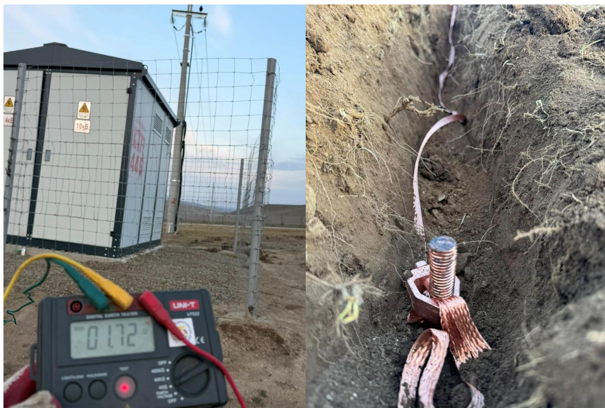
Зураг.11 Газардуулга хийсэн байдал
