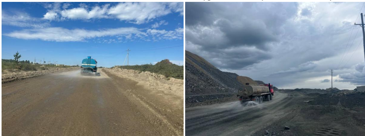
Зураг-2.5. Зам усалгаа хийж буй байдал.
