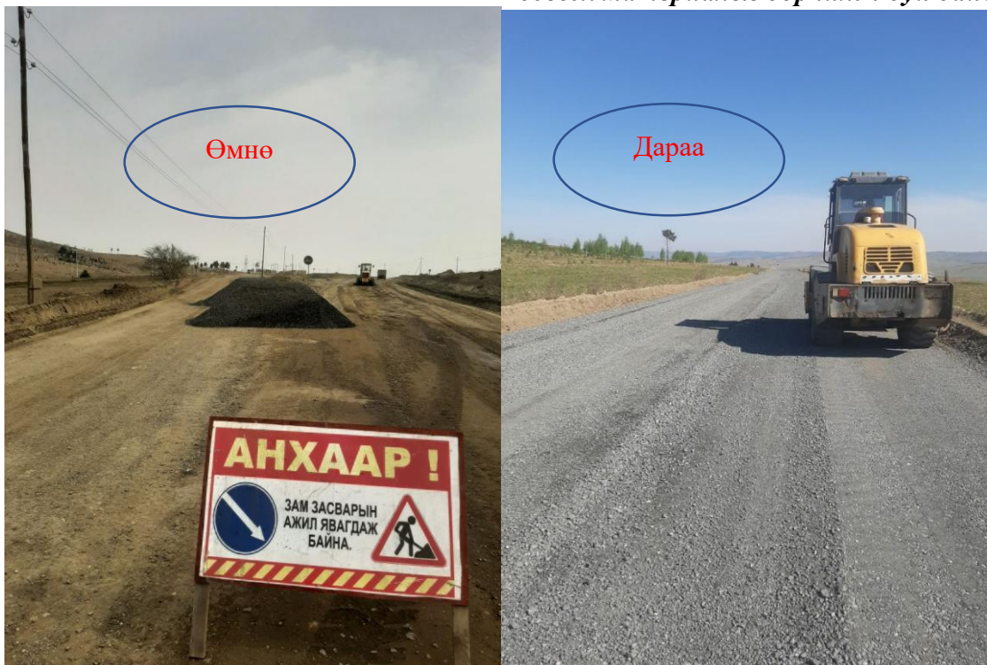
Зураг-2.2. Зам дээр дэвсэх материалын судалгаа хийж, дэвсэх материалыг өөрчилж буй байдал.
