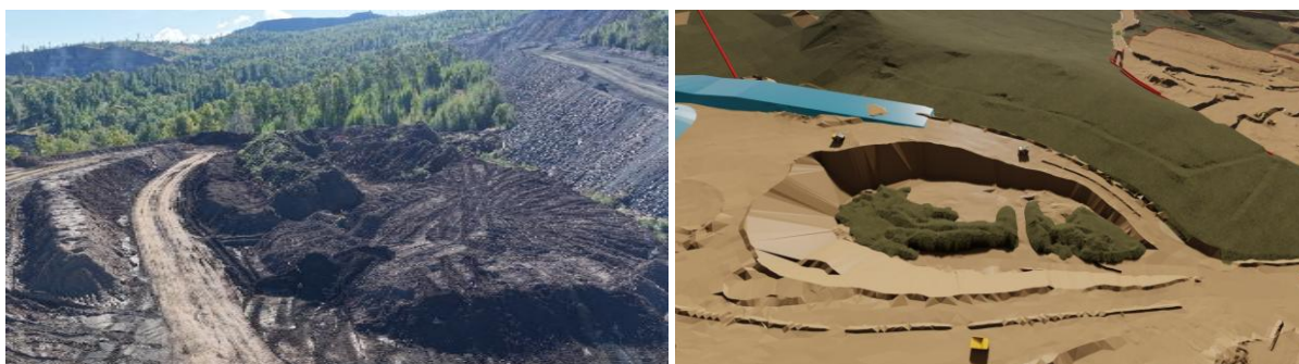
Зураг № 2.11 Шимт хөрсний овоолгыг хэлбэршүүлсэн байдал
