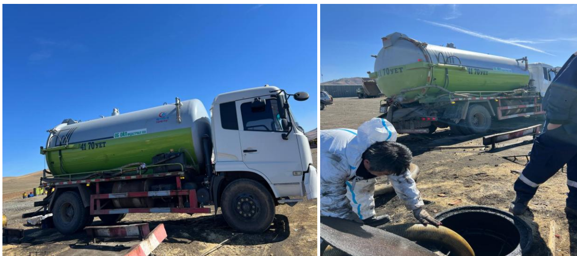
Зураг № 8.6 Тусгай зориулалтын машинтай ирж соруулж авч буй явц
