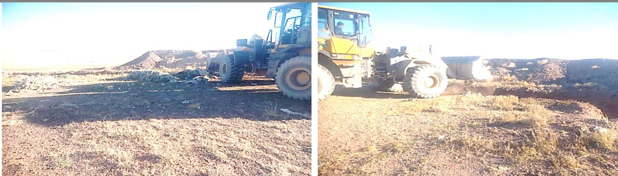
Зураг №26, 27. Хог хаягдлыг ашиглалтын талбайн гадна талд нүх ухаж хаясан орчмыг цэвэрлэх, нүхийг булж нөхөн сэргээж буй байдал
