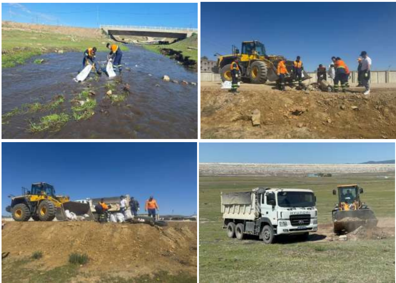
Зураг 94. Хангал голын цэвэрлэгээний хог ачиж буй байдал.
