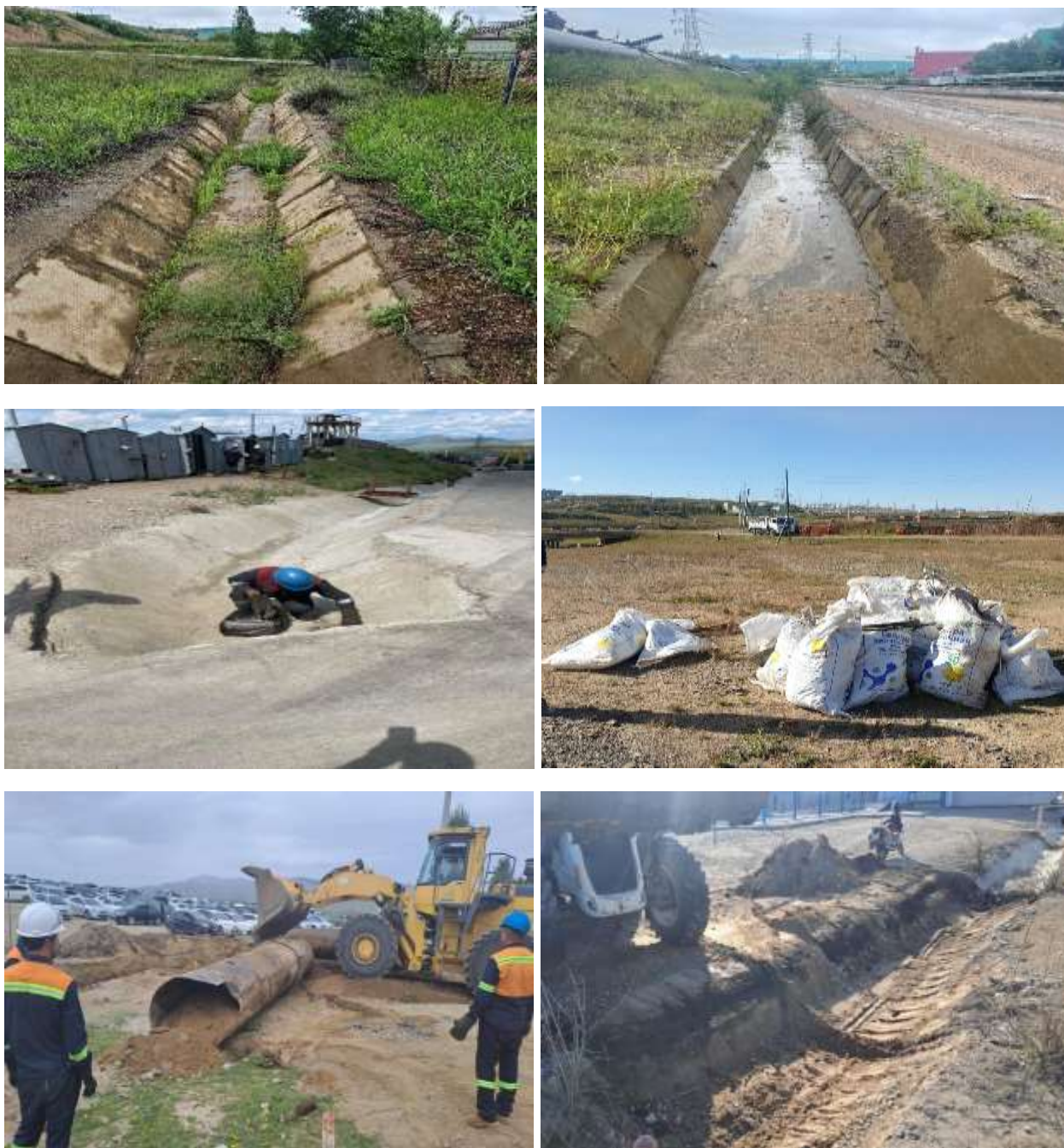
Зураг 57. Суваг цэвэрлэх, засварлах ажлын явц
