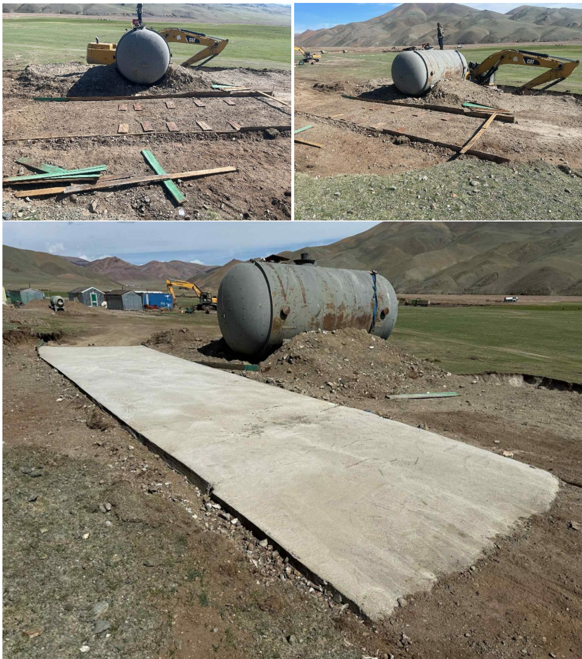
Зураг 17. ШТС-ын цэнэглэх, түгээх хэсгийг хатуу хучилттай болгосон
