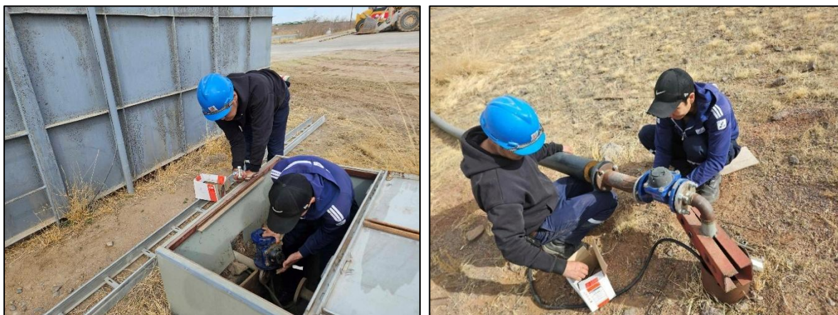
Зураг 9. Тоолуур суурилуулалт
