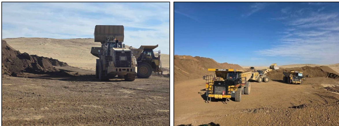
Зураг 14. Шимт хөрсний зөөх үе
