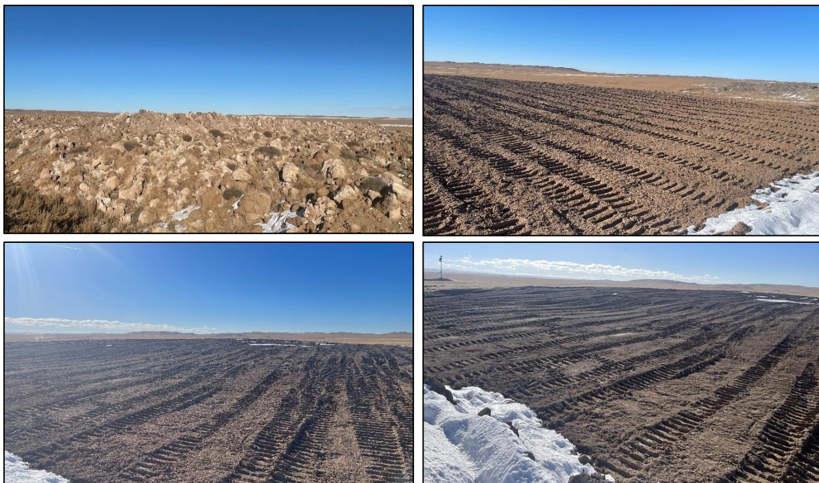
Зураг 13. Шимт хөрсөөр дотоод овоолгийн дүүргэлт хийж, биологийн нөхөн сэргээлтэнд бэлтгэсэн
