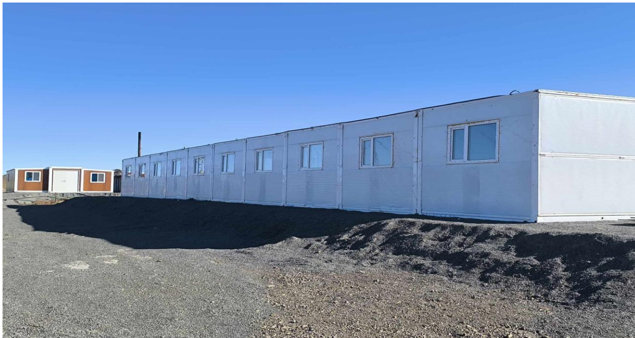
Зураг 5. Ажилчдын шинэ сууц
