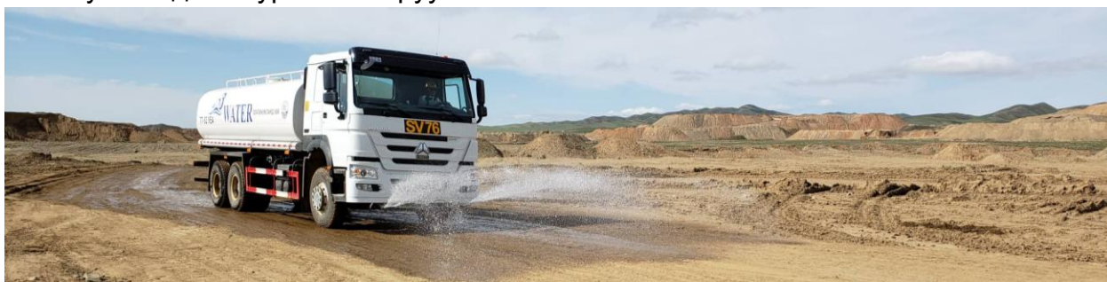
Зураг 2.2. Технологийн зам усалгаа хийгдэж буй байдал.
