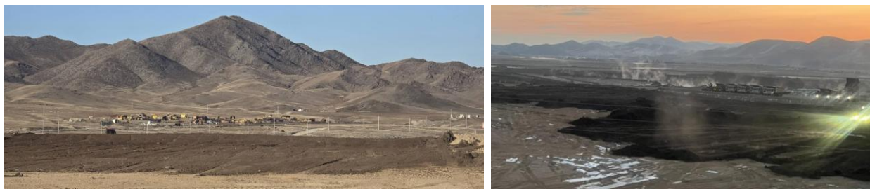
Зураг 2.7. Техникийн нөхөн сэргээлт хийгдэж буй байдал.
