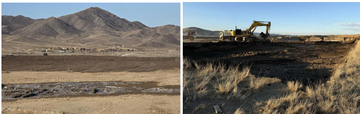
Зураг 2.5. Үржил шимт хөрсийг хуулж буй байдал.
