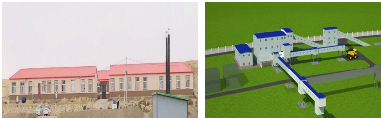
Ажилчдын амрах байр, Нүүрс угаан баяжуулах үйлдвэрийн харагдах байдал
