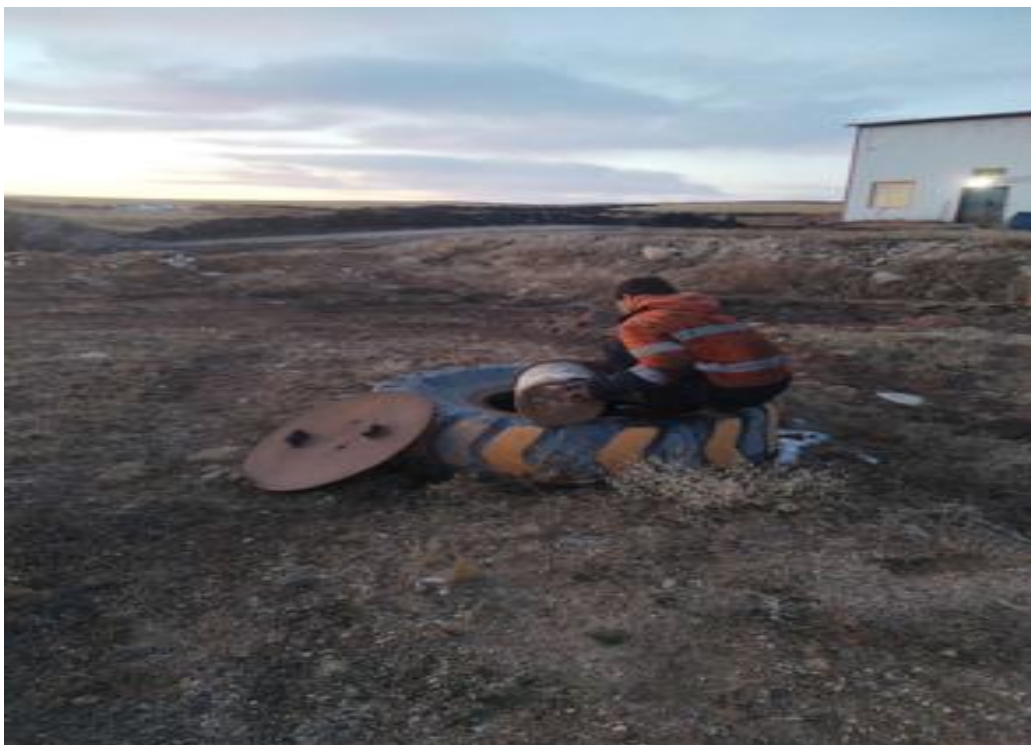
Ахуйн бохир усны цооногт ариутгал хийж байгаа нь
