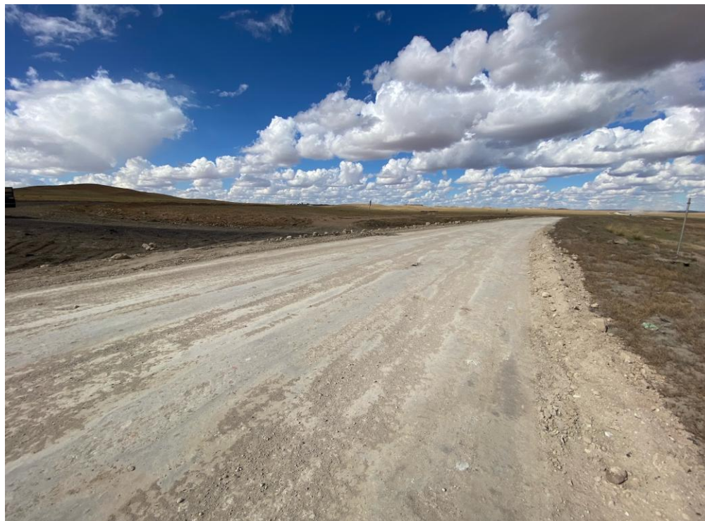
Замын суларсан тоос шороог тогтмол хусч зарим хэсэгт шороо зөөж дүүргэлт болон тэгшилгээний ажил хийсэний дараа
