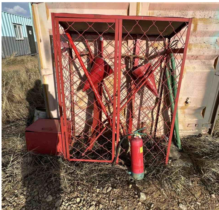
Зураг № 18 Галын сарааг ШТС талбайд байршуулсан байдал, уурхайн техник бүрд галын аюулгүй байдлыг хангаж буй байдал
