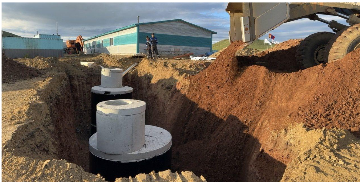
Зураг № 26 Ахуйн бохир цэвэрлэх байгууламж суурьлуулж байгаа байдал
