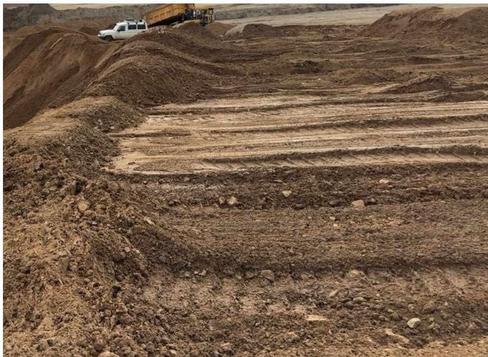
Зураг № 21 Дотоод овоолгоор техникийн нөхөн сэргээлт хийж буй байдал
