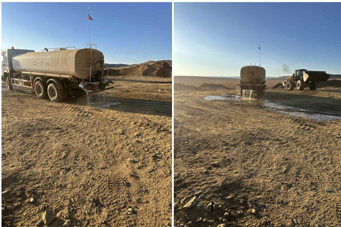
Зураг № 6 Зам усалгааны ажил хийгдэж буй байдал
