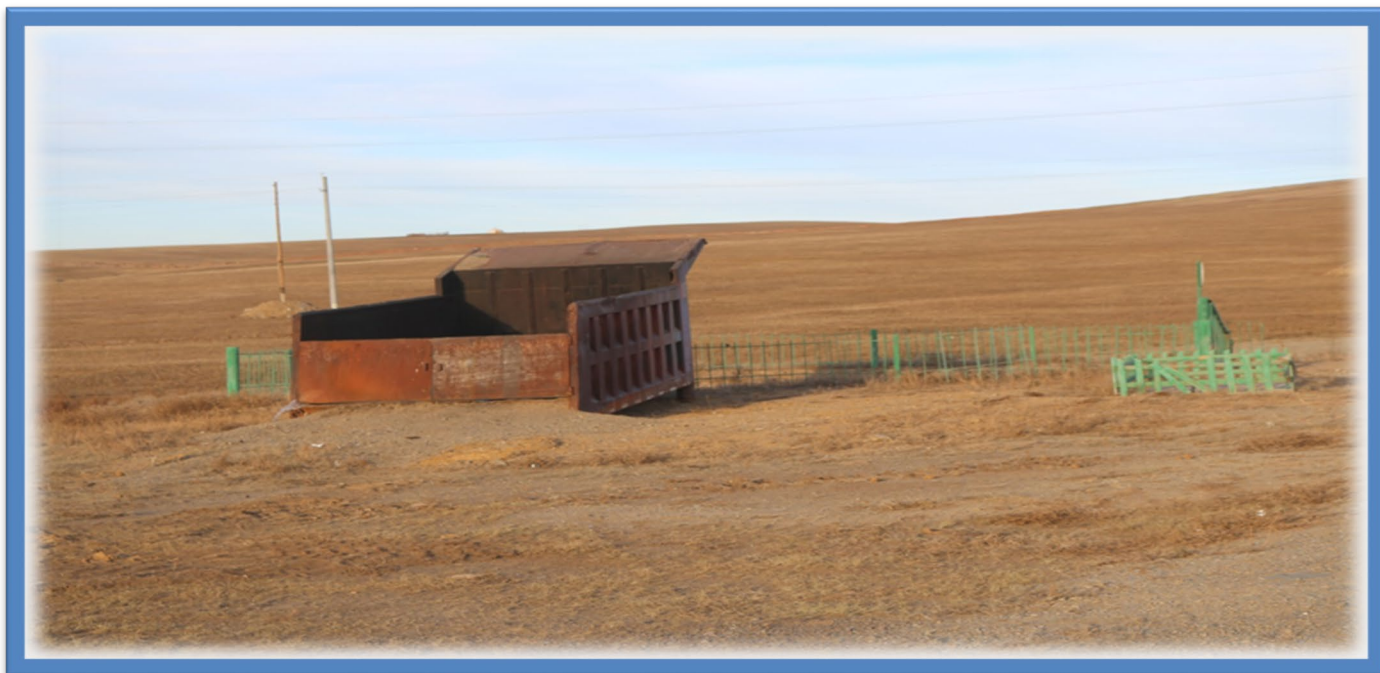
Зураг №31 Энгийн хог хаягдал түр хадгалах цэг
