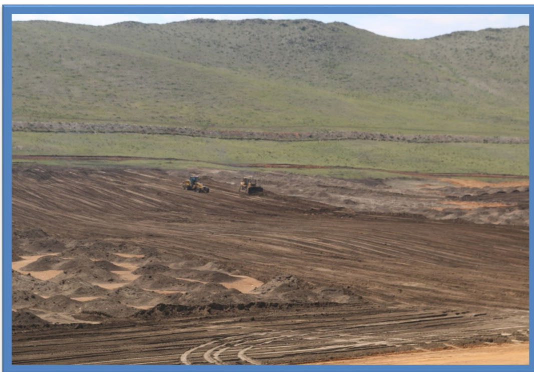
Зураг № 17 Автогрейдер болон бульдозероор хэлбэржүүлэлтийн ажил явагдаж байна.
