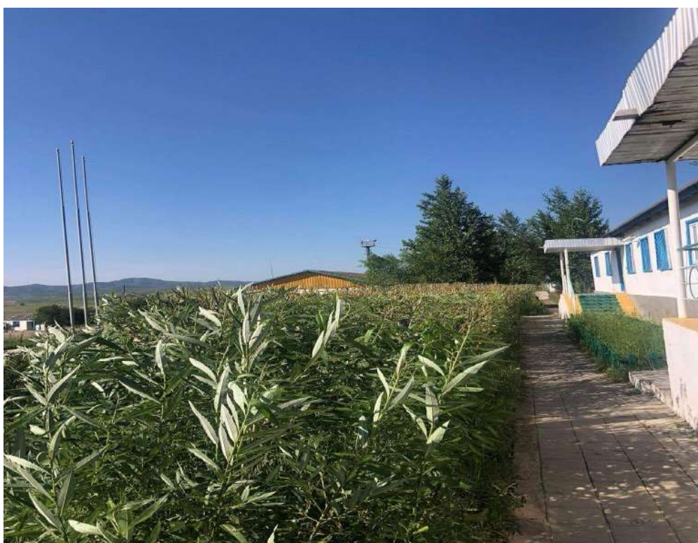
Зураг 13. Ногоон байгууламжийн ажлууд хийгдэж буй байдал
