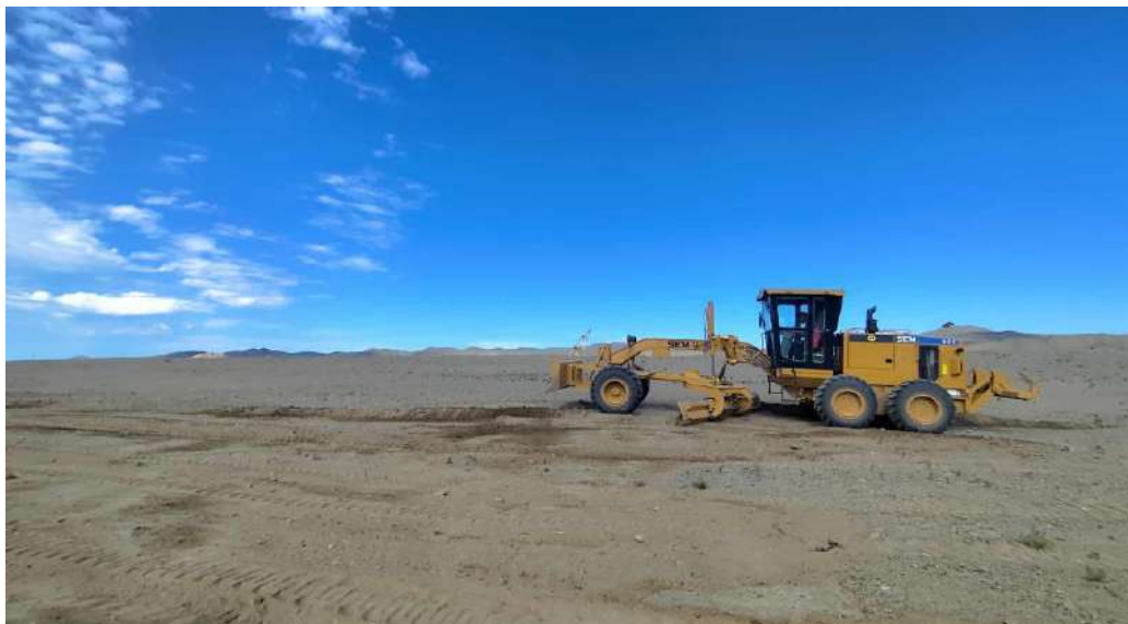
Зураг 9. Хөрс хуулалтын гадаад овоолгыг драгийн олборлолт явагдсан мөрөгцөгийн орон зайг дүүргэн Катерпиллер D9R. 2 ширхэг бульдозеруудаар тэгшилэн автогрейдерээр өнгөлгөө хийж буй байдал.
