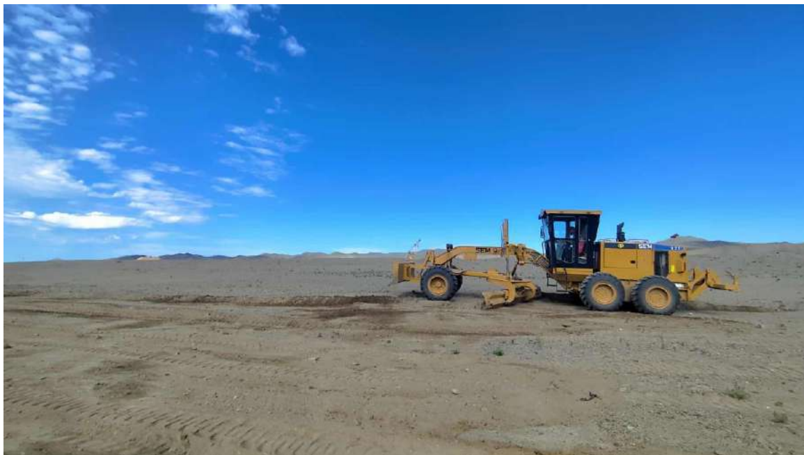
Зураг 8. Хөрс хуулалтын гадаад овоолгыг драгийн олборлолт явагдсан мөрөгцөгийн орон зайг дүүргэн Катерпиллер D9R. 2 ширхэг бульдозеруудаар тэгшилэн автогрейдерээр өнгөлгөө хийж буй байдал.
