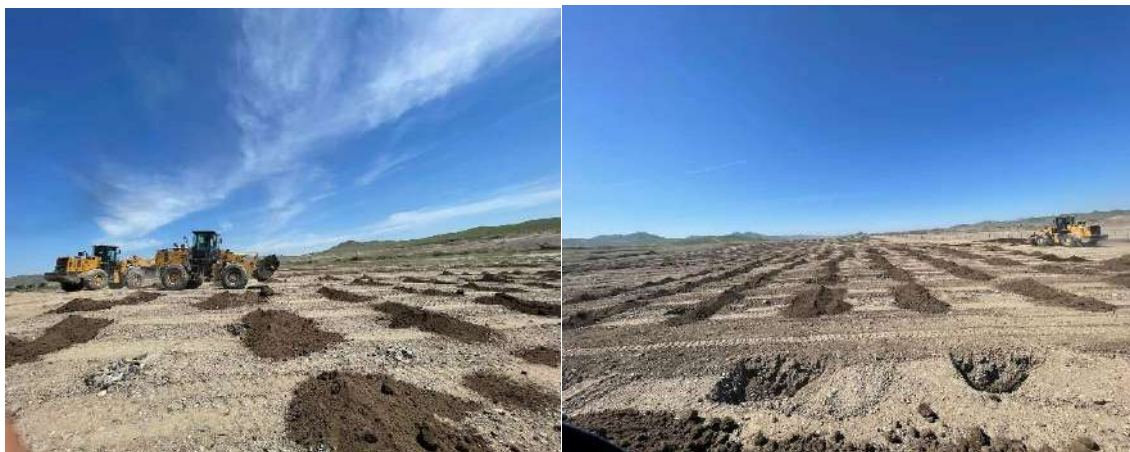
Зураг 11. Дампаар буулгуулсан хөрсийг ковшоор тогоо бүрт тарааж буй байдал
