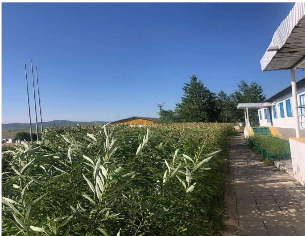
Зураг.19 Ногоон байгууламжийн ажлууд хийгдэж буй байдал
