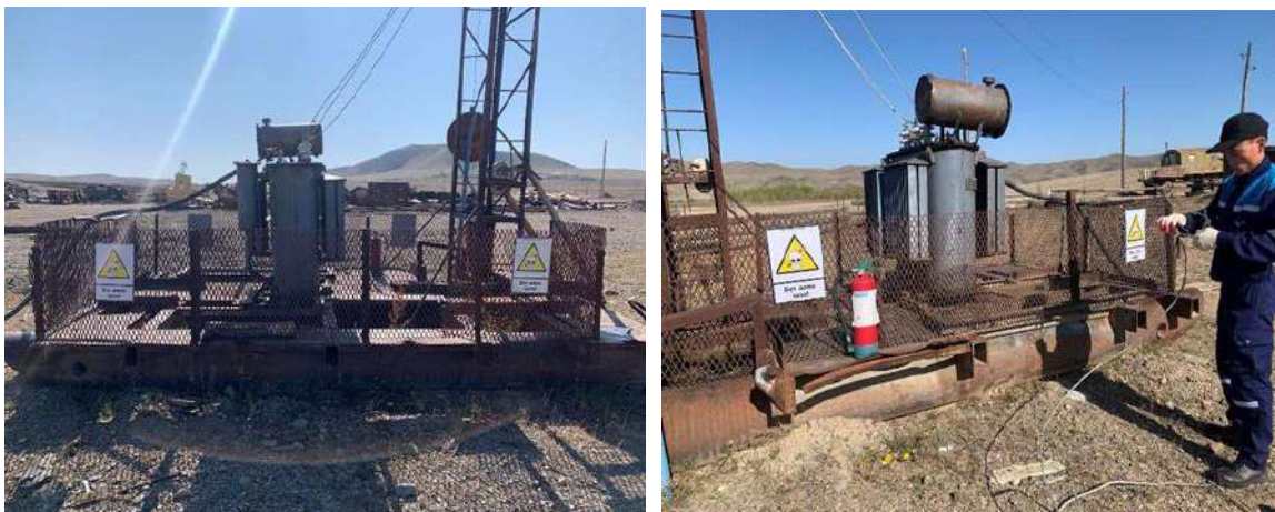
Зураг 33. Засварын талбайн өндөр хүчдэлийн трансформаторын гадна талын торон хашаанд ХАБ-ын шаардлагын дагуу АНХААРУУЛАХ ПЛАКАД -нуудыг дөрвөн талд нь байршуулж, цахилгаан хүчдэлд нэрвэгдэх эрсдэлийг бууруулж ажилласан.
