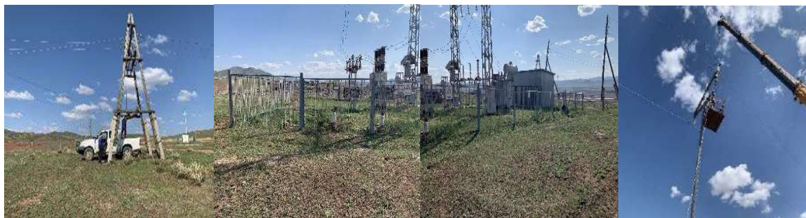
Зураг 28. Уурхайн урд, хойд 35 кВ-ын цахилгааны дэд станцуудад, төлөвлөгөөт үзлэг, засвар хийж буй байдалд хяналт тавьж, цахилгаан хүчдэлд нэрвэгдэх эрсдэлийг бууруулахад анхаарал тавьж ажилласан.
