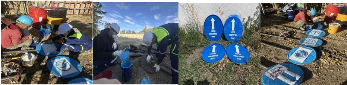
Зураг 31. Хуучирч, элэгдсэн, будаг нь бүдгэрсэн, эвдэрч хаягдсан тэмдэг тэмдэглэгээнүүдийг цуглуулж, засварлаж, шинэчлэн будаж, шаардлагатай байгаа тэмдэг болгон цоолборложбудсан, байрлуулахад бэлэн болсон тэмдэгнүүдийн байдал.
