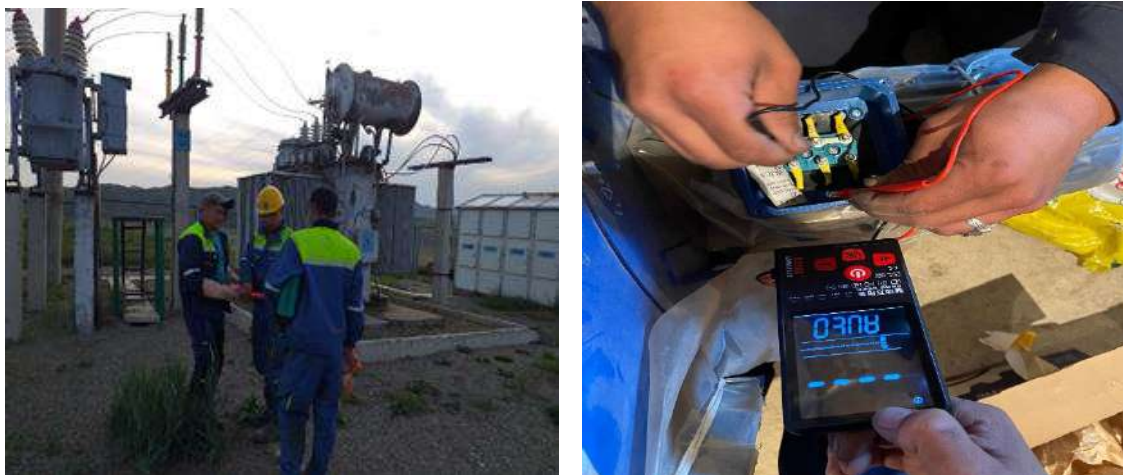
Зураг 46. Цахилгааны үзлэг шалгалт хийж буй нь
