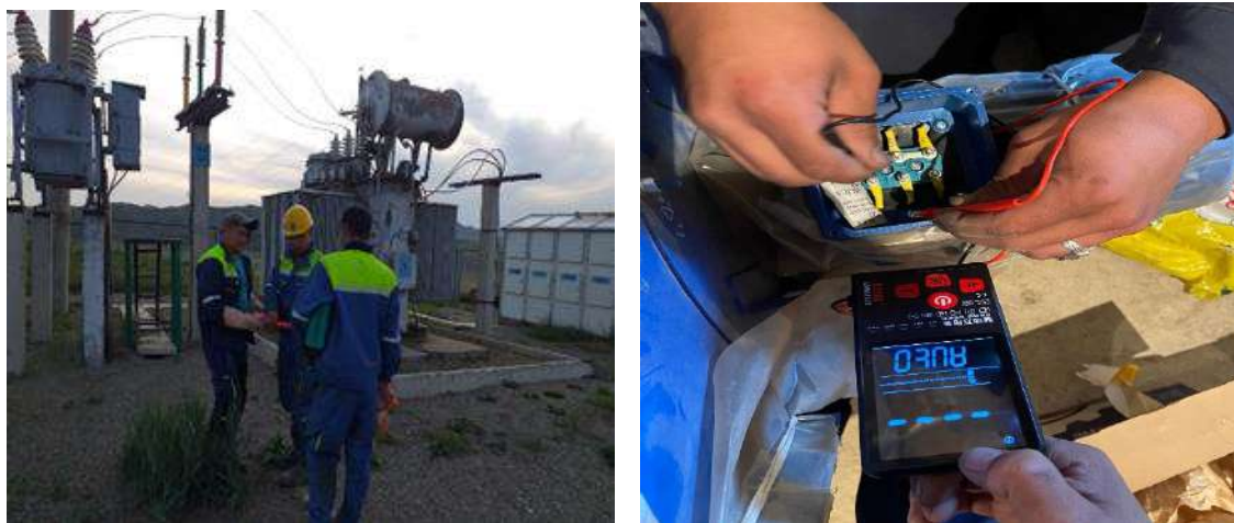
Зураг 35. Цахилгааны үзлэг шалгалт хийж буй нь
