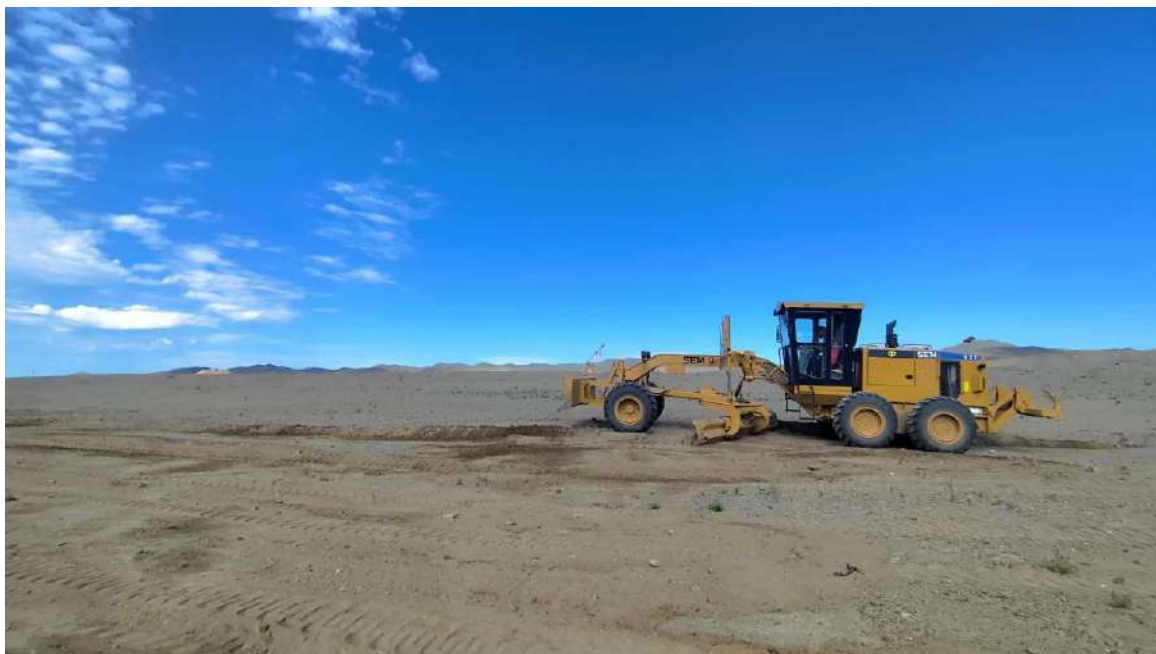
Зураг 8. Хөрс хуулалтын гадаад овоолгыг драгийн олборлолт явагдсан мөрөгцөгийн орон зайг дүүргэн Катерпиллер D9R, 2 ширхэг бульдозеруудаар тэгшлэн автогрейдерээр өнгөлгөө хийж буй байдал.
