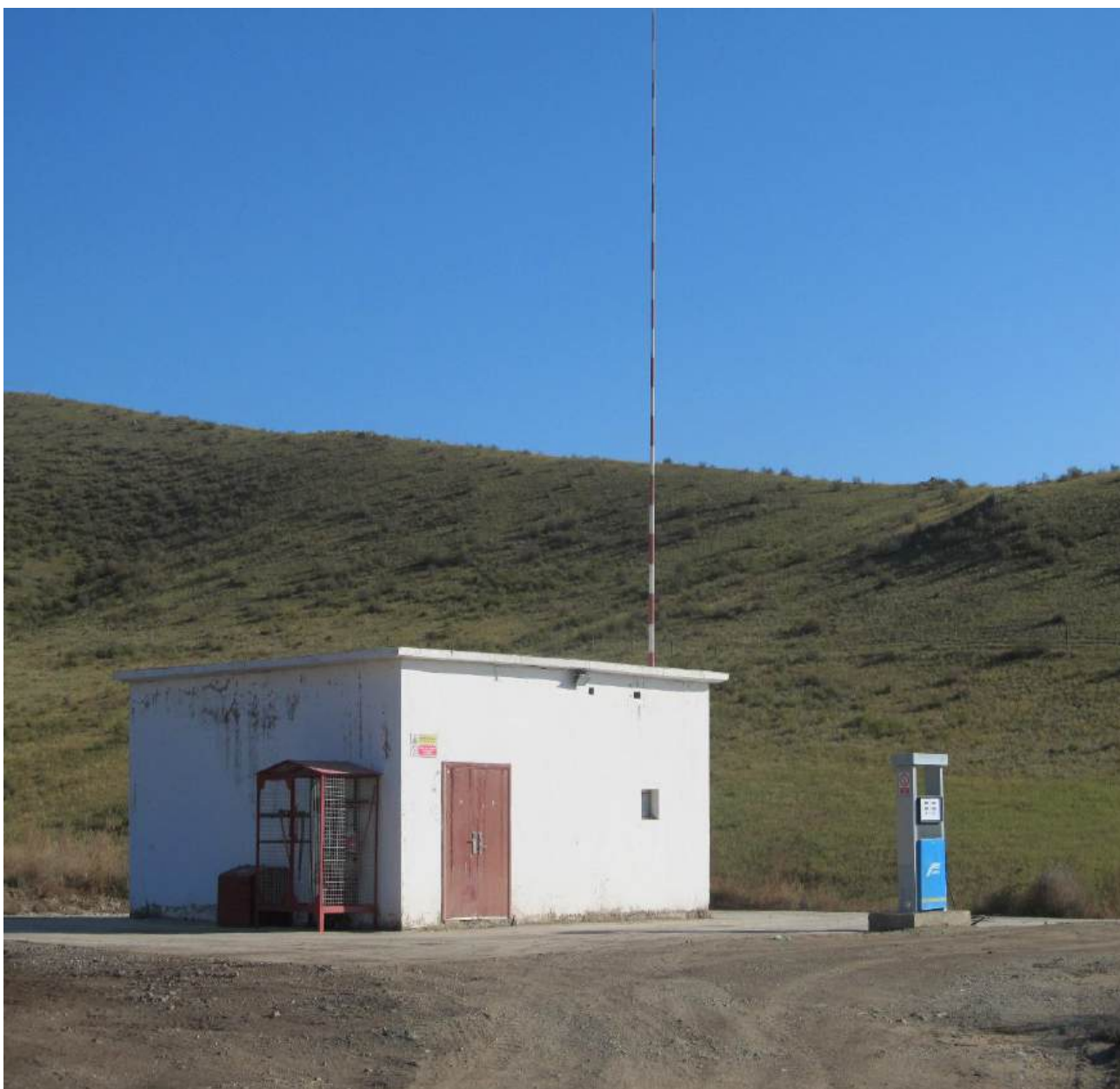
Зураг 18. Шатахуун түгээх станц
