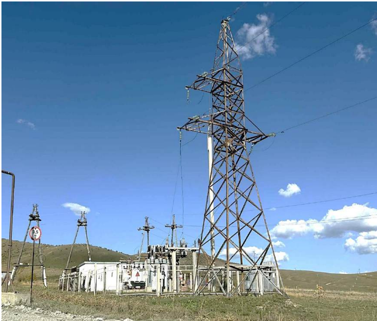
Зураг 9. Уурхайн дэд станц оролтын шугамын хүчин чадал (35000V)
