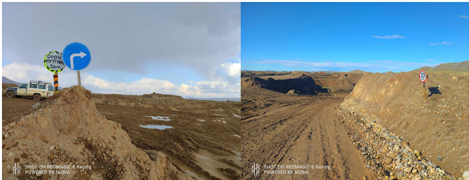
Зураг 5. Замын тэмдэг тэмдэглэгээ болон хурдны хязгаар заасан тэмдэг, тэмдэглэгээ тавьсан байдал
