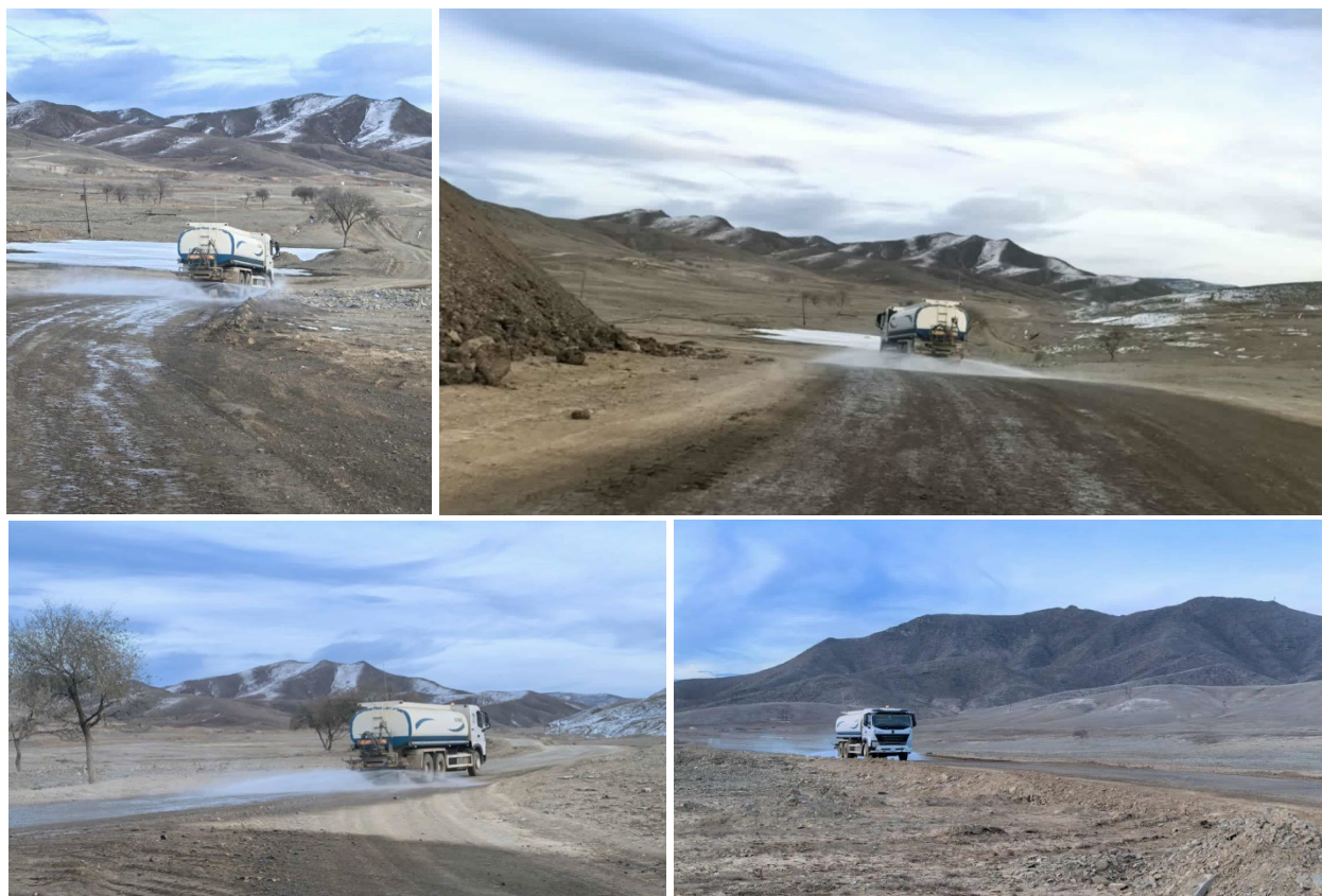
Зураг № 1. Замын усалгаа хийгдэж байгаа байдал
