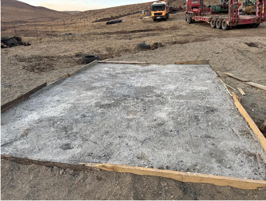
Зураг-14. Засварын талбайг бетондсон
