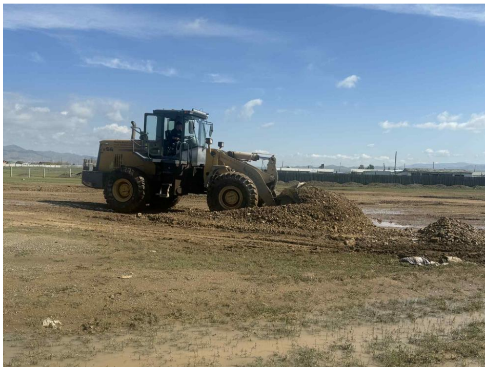
Зураг 3. Орчины сөрөг нөлөөллийг бууруулах ажлын хүрээнд тээврийн хэрэгсэл явах карьерийн зам дээр хайрга асгаж тэгшилэх ажилын явц
