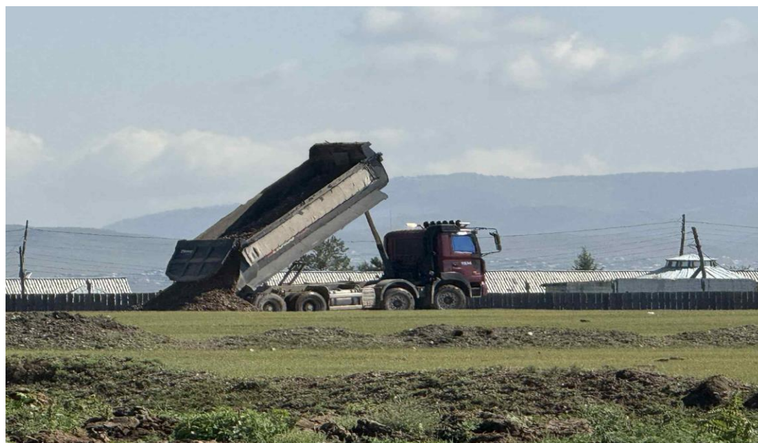
Зураг 16.Орон нутгийн замын эвдрэлийг засварлаж тэгшилжэ байгаа ажлын явц.
