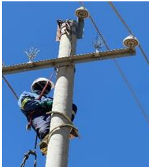
Зураг 4.3.8.1 Шаардлагын дагуу заагдсан газруудад шувуу үргээгч суурьлуулж буй байдал.
