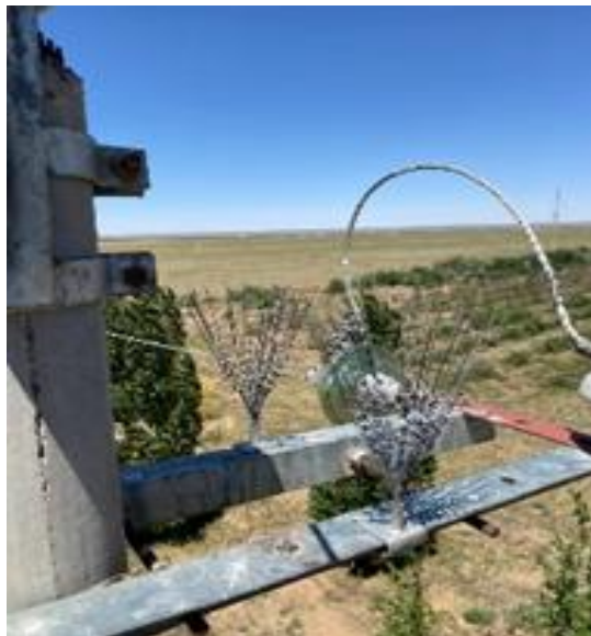
Зураг 4.3.8.1 Шаардлагын дагуу заагдсан газруудад шувуу үргээгч суурьлуулж буй байдал.
