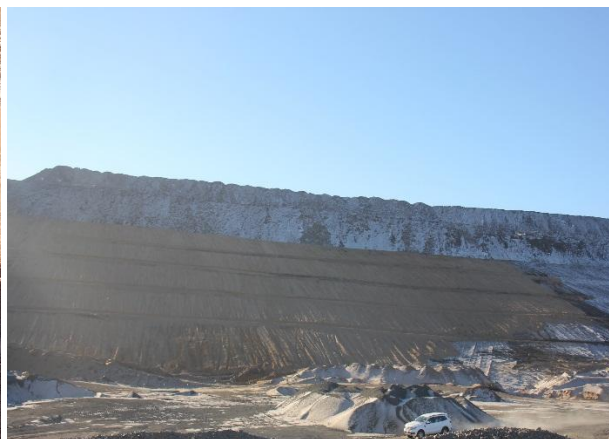
Зураг 5.2.1. Хаягдлын овоолгын талбайг шимт хөрсөөр хучиж буй байдал
