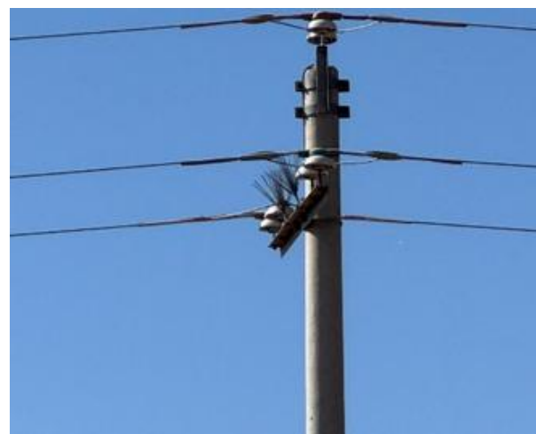
Зураг 4.3.9.1 Шувууг хүчдэлд нэрвэгдэхээс хамгаалсан бүрээсүүдэд үзлэг хийж сайжруулсан байдал.
