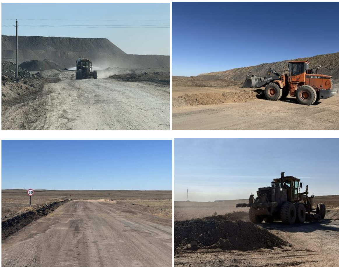
Зураг. 4.5.2 Замын тэгшилгээ, хамгаалах хөмсөг хийж байгаа байдал
