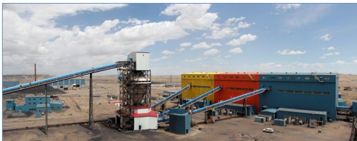
Зураг 1.2. Нүүрс баяжуулах үйлдвэр
