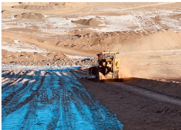
Зураг 5.2.1. Хаягдлын овоолгын талбайг шимт хөрсөөр хучиж буй байдал
