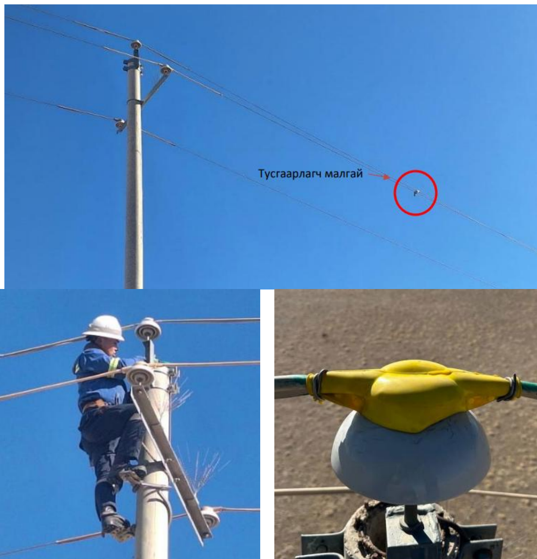
Зураг 4.3.9.2 Тусгаарлагч малгай бэхэлгээ салж утсанд тохогдсоныг засан сайжруулж тусгаарлагч малгай шинээр хийсэн байдал.
