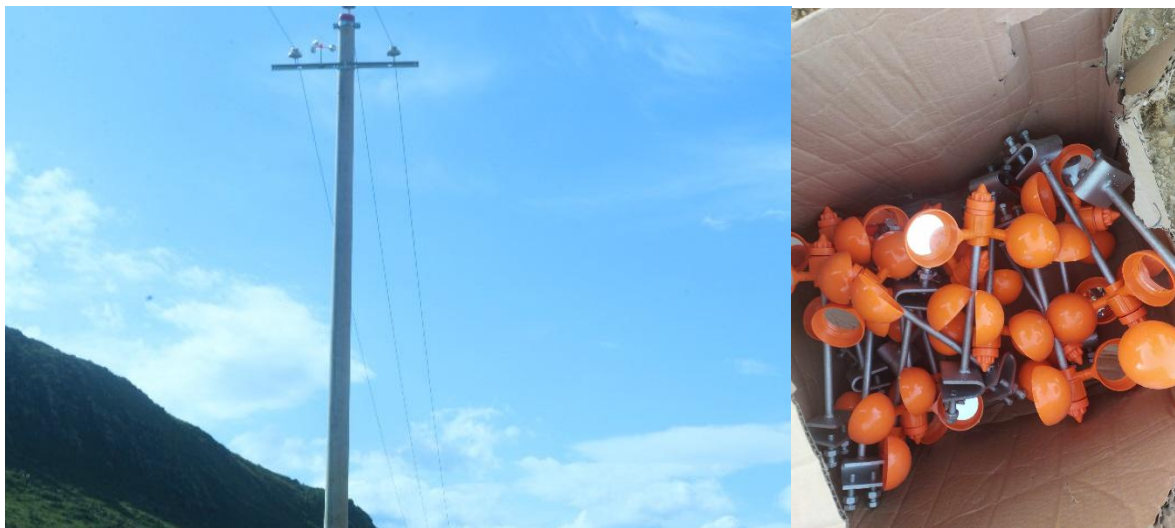
Зураг.15 Уурхайд байрлах нийт 10 ширхэг тулгуур дээр шувуу үргээгч суурилууллаа.
