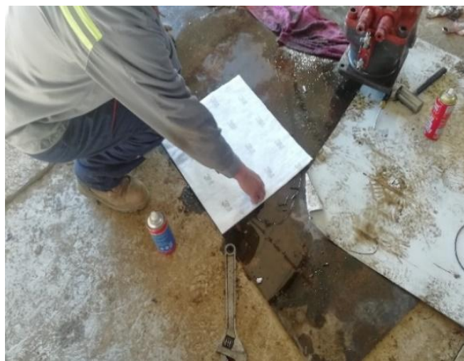
Зураг.10 Нефтийн бүтээгдэхүүн асгарсан тохиолдолд авах арга хэмжээ, Spill kit / Асгаралт шингээгч
