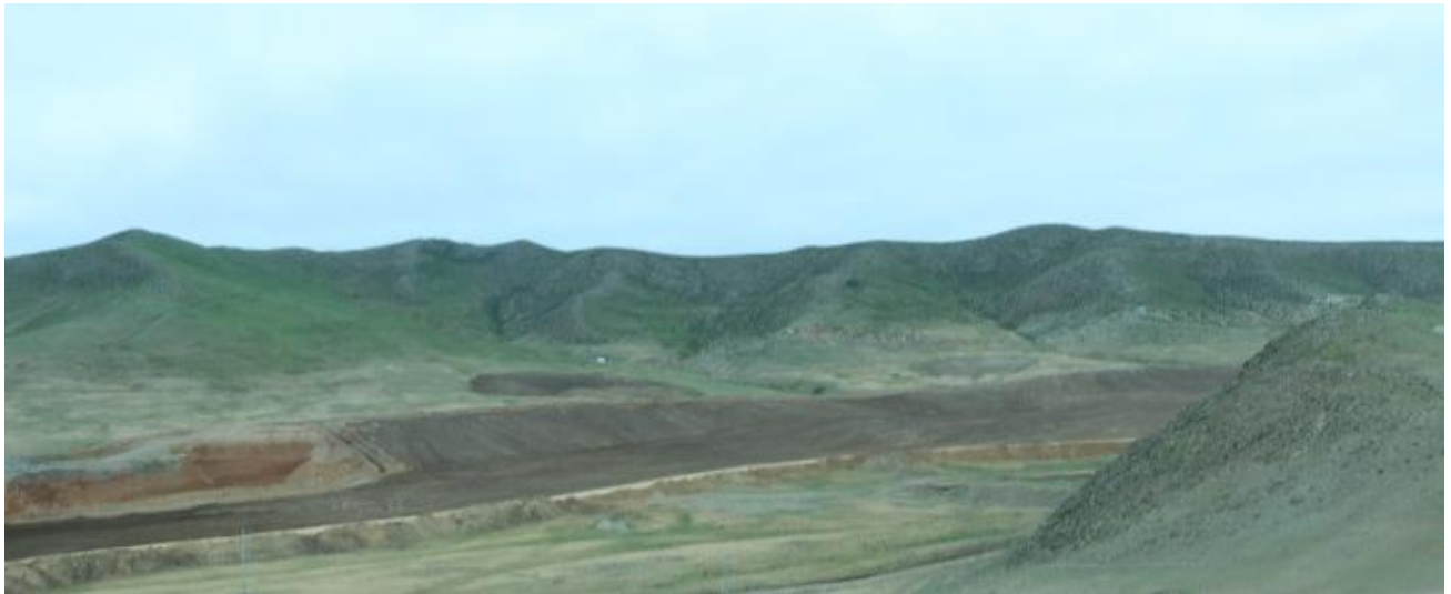
Зураг.21 16.4 га талбайд 20 см зузаантайгаар шимт хөрсөөр дэвсэлт
