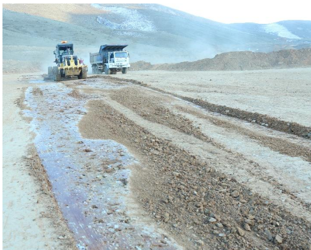
Зураг.2 Тээврийн замд эфелээ дэвсэлт хийж, автогрейдерээр тэгшилэв.
