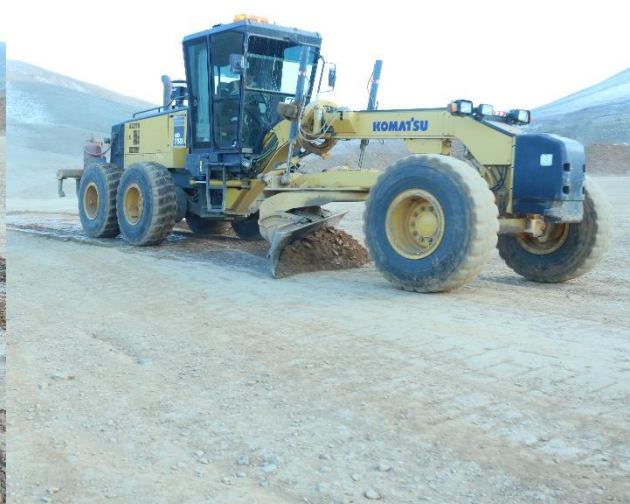
Зураг.2 Тээврийн замд эфелээ дэвсэлт хийж, автогрейдерээр тэгшилэв.
