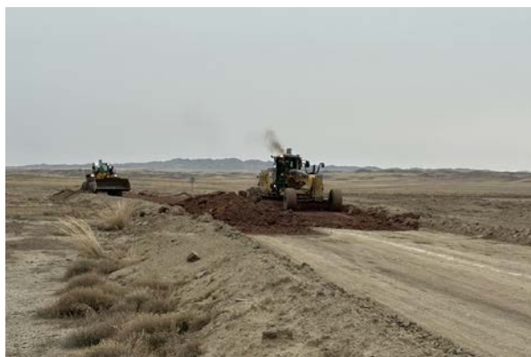
Зураг 4.1.2.3 Уурхайн замын тоос, тоосонцор дэгдэхээс сэргийлж Технологийн замуудад материал дэвсэлт хийсэн.
