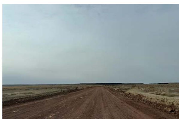
Зураг 4.1.2.3 Уурхайн замын тоос, тоосонцор дэгдэхээс сэргийлж Технологийн замуудад материал дэвсэлт хийсэн.
