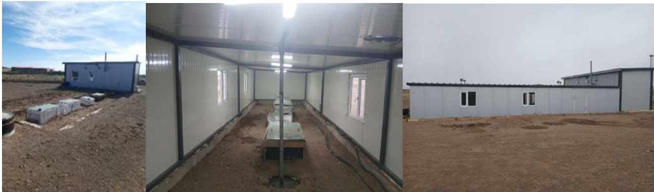
Зураг 4.2. Цэвэрлэх байгууламжийн 5 танкны дулаалга 15х4 харьцаатай сендвичэн барилга барьсан
