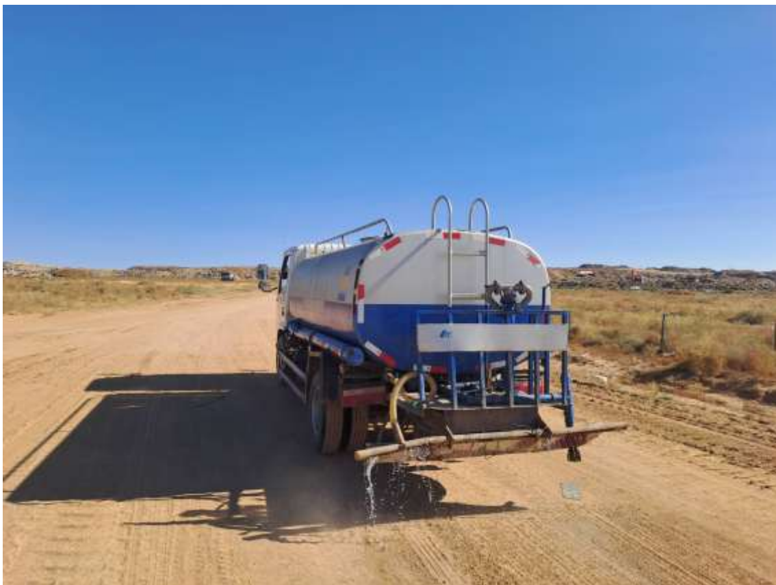
Зураг 2. Уурхайн зам талбайд усалгаа хийжэ байгаа нь
