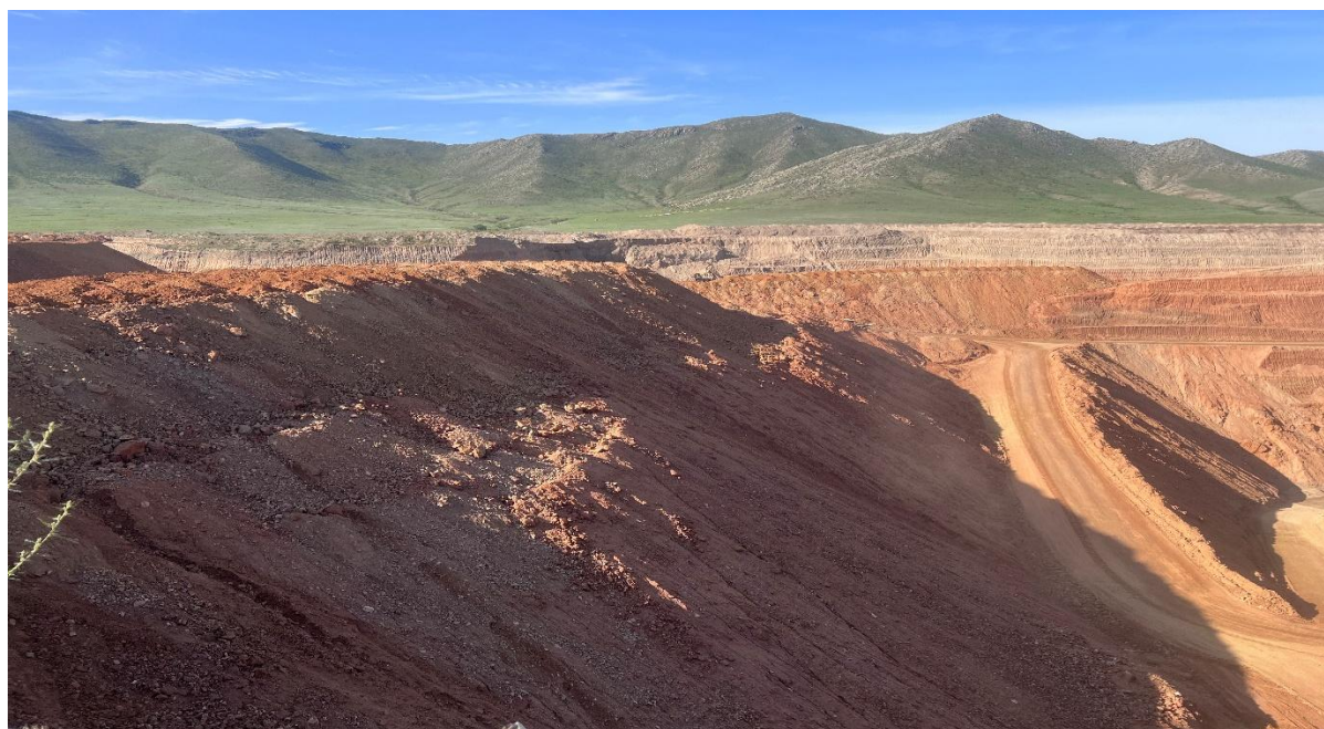
Зураг №2. Дотоод овоолгоор дүүргэлт хийж байх үеийн байдал
