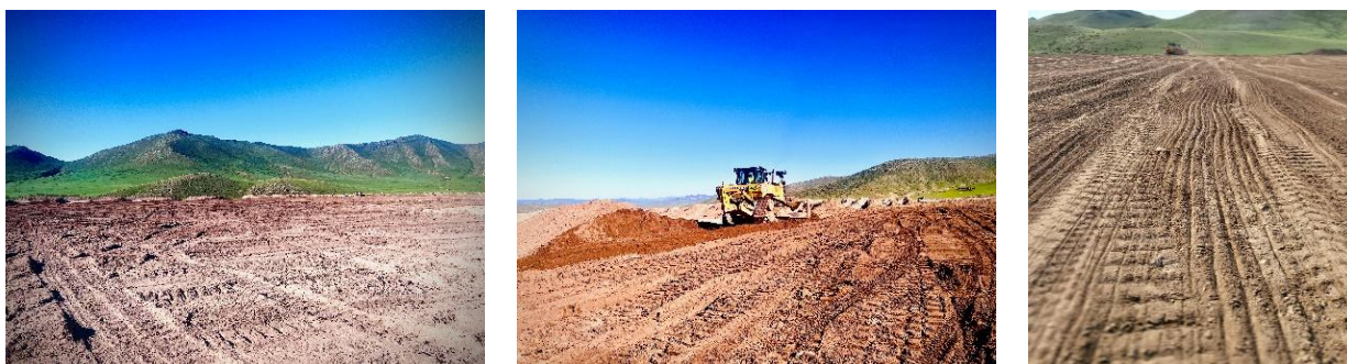
Зураг №5. Талбайн хөрс бэлдэх явц
