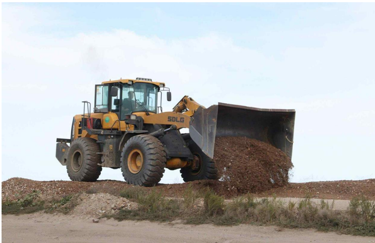
Зураг 29. Хэрлэн сумын 5-р багт зам, гүүрийн ажилд ковш, авто тээвэрлэлтээр тусалсан байдал
