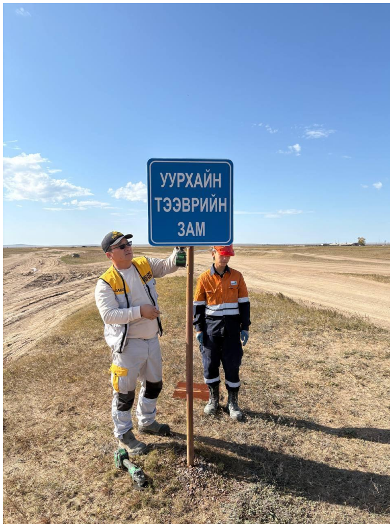
Зураг 7. Замын тэмдэг тэмдэглэгээ шинэчилсэн байдал
