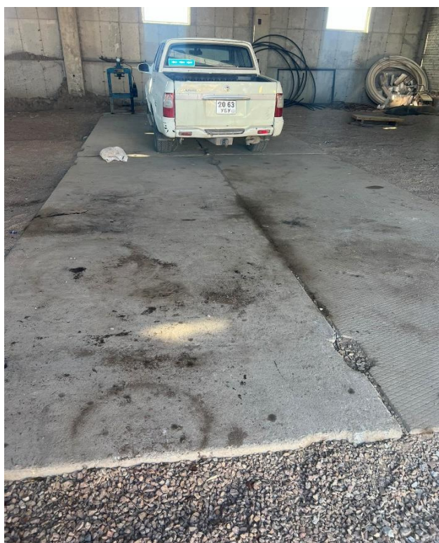
Зураг 19. ШТМ болон аюултай хог хаягдлыг хадгалах талбайг хатуу хучилттай болгосон байдал
