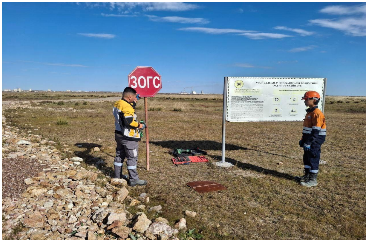
Зураг 5. Замын тэмдэг тэмдэглэгээ шинэчилсэн байдал
