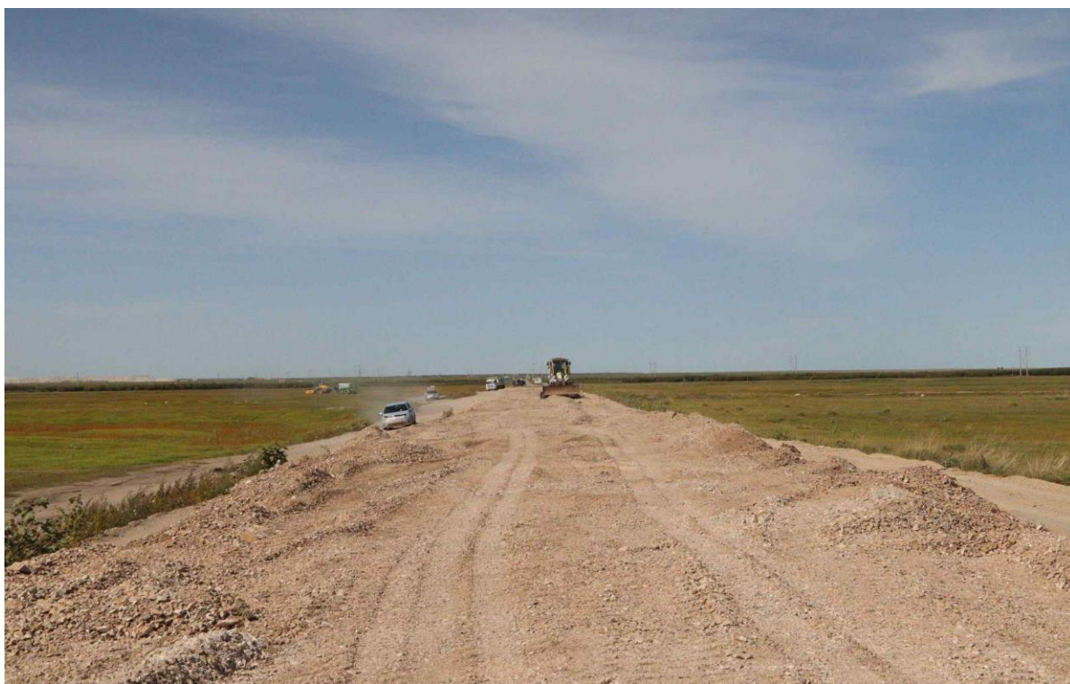
Зураг 30. Хэрлэн сумын 5-р багт зам, гүүрийн ажилд ковш, авто тээвэрлэлтээр тусалсан байдал
