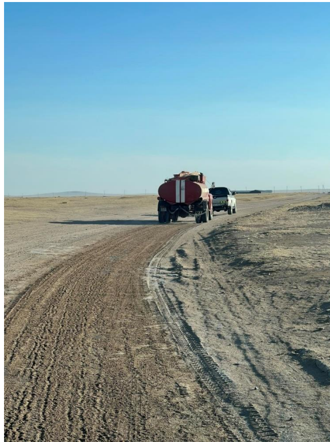
Зураг 2. Зам талбайд усалгаа хийгдэж байгаа байдал
