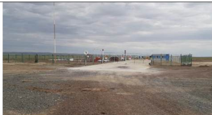
Дээж-5 Шатахуун түгээх станц
