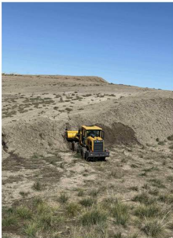
Хийгдэж буй байдал
