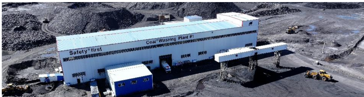
Зураг 15.Нүүрсийг нойтон технологиор баяжуулах үйлдвэр
