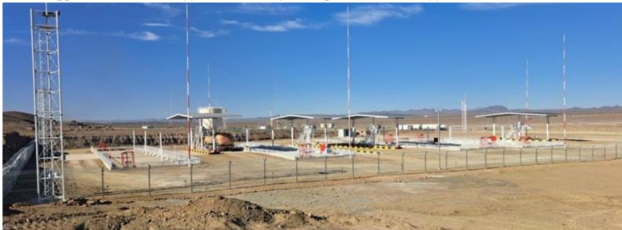
Зураг 8.Шатахуун түгээх станц
