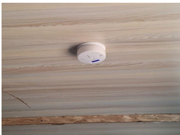
Уурайн оффис болон амрах байрны өрөөнүүдэд галын дохиолол өгөх төхөөрөмж
