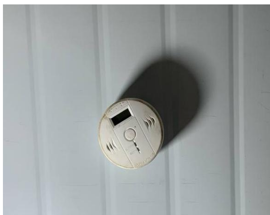
Уурайн оффис болон амрах байрны өрөөнүүдэд галын дохиолол өгөх төхөөрөмж
