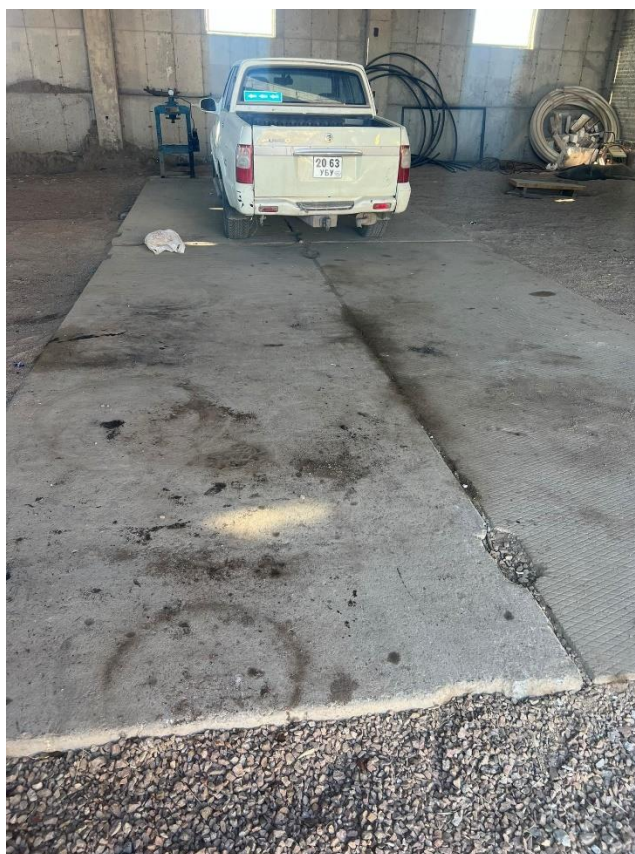
Зураг 23. Ашигласан ШТМ хадгалах газрыг хатуу хучилттай болгосон байдал
