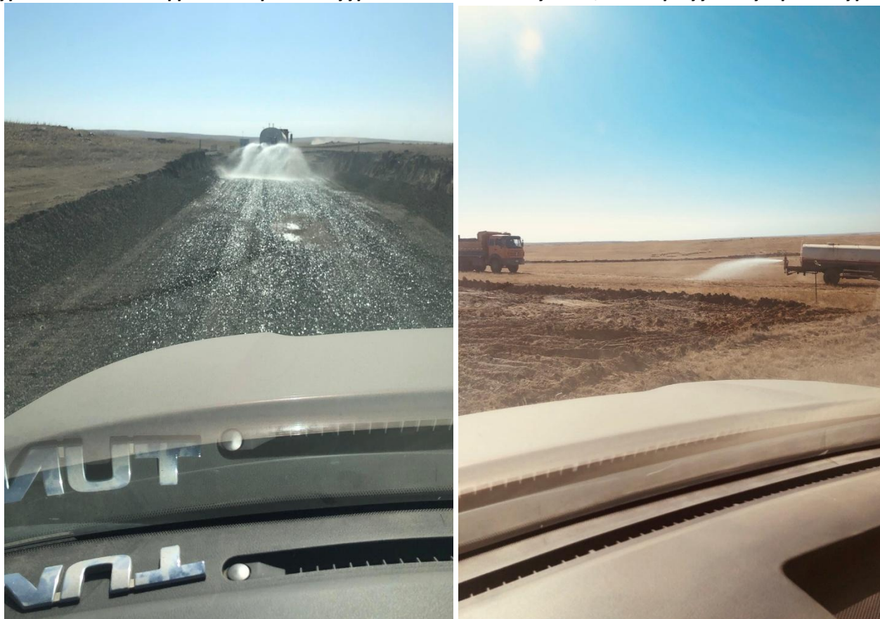
Зураг 3: Тоосжилт үүсэхээс сэргийлэн уурхайн зам талбайг услаж, дагтаршуулж буй үеийн зураг
