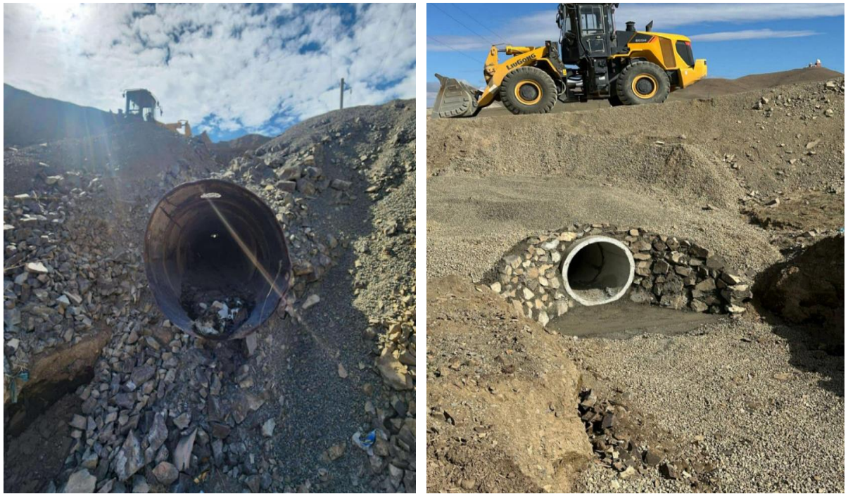
Зураг № 7 Ус зайлуулах хоолойг сайжруулсан байдал
