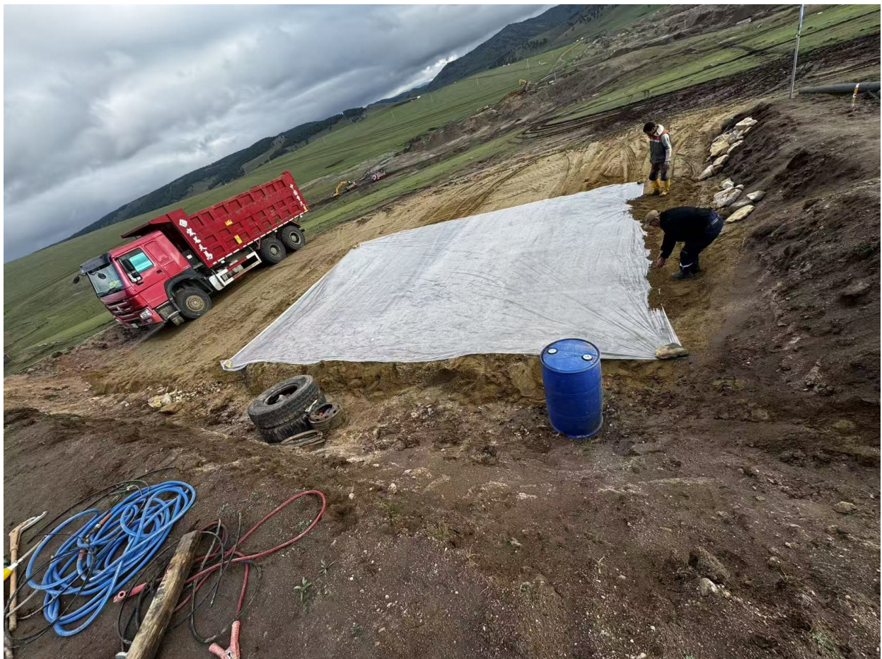
Зураг 3. Засварын талбайн суурийг ус үл нэвчих материалаар хучиж буй зураг
