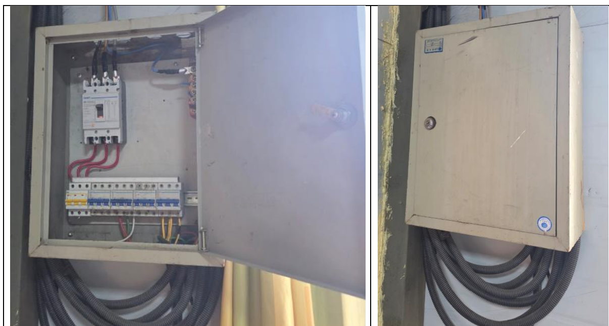
Зураг 24. Цахилгааны монтаж
