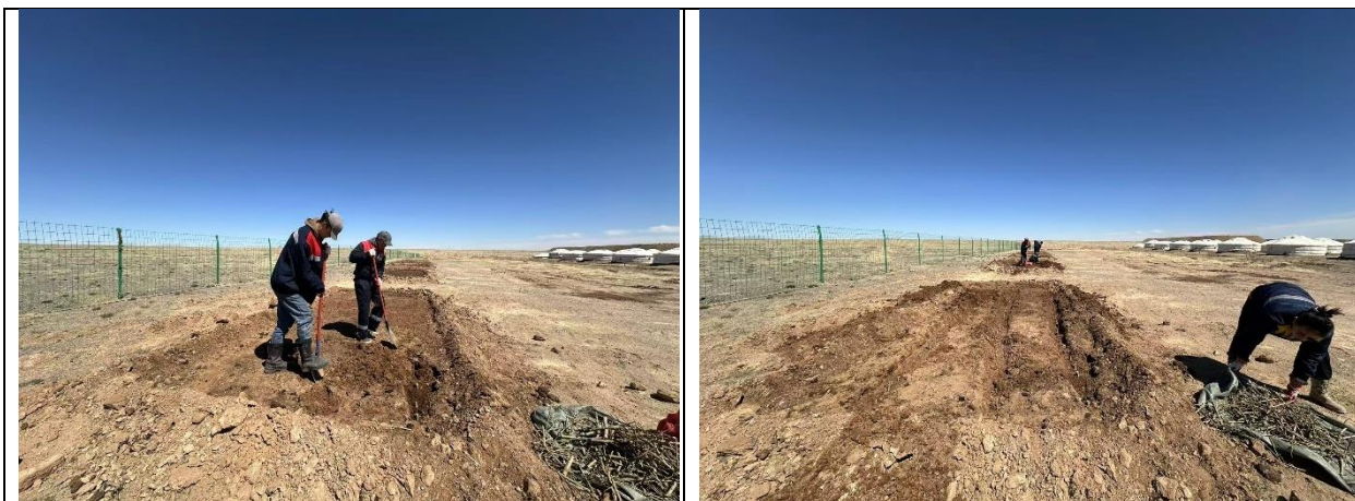
Үрсэлгээ суулгах талбай бэлтгэж буй байдал
