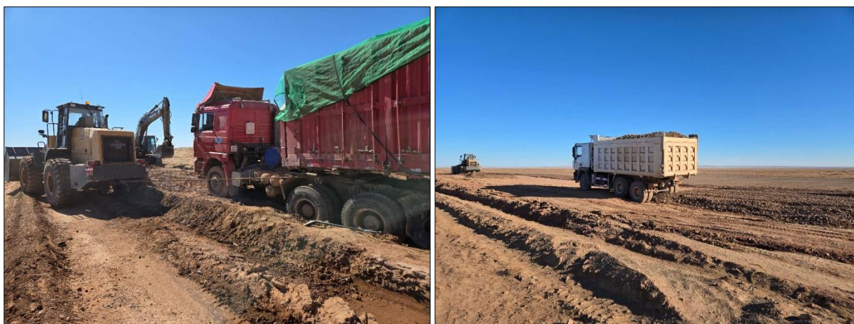
Зураг № 26. Нүүрс тээврийн засвар, засвар, тоосжилт бага үүсэх хайрга материал дэвсгэлтийн ажил
