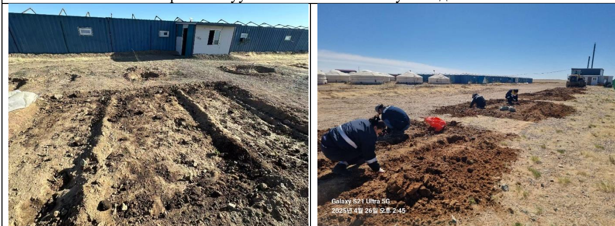
Үрсэлгээ суулгаж буй байдал
