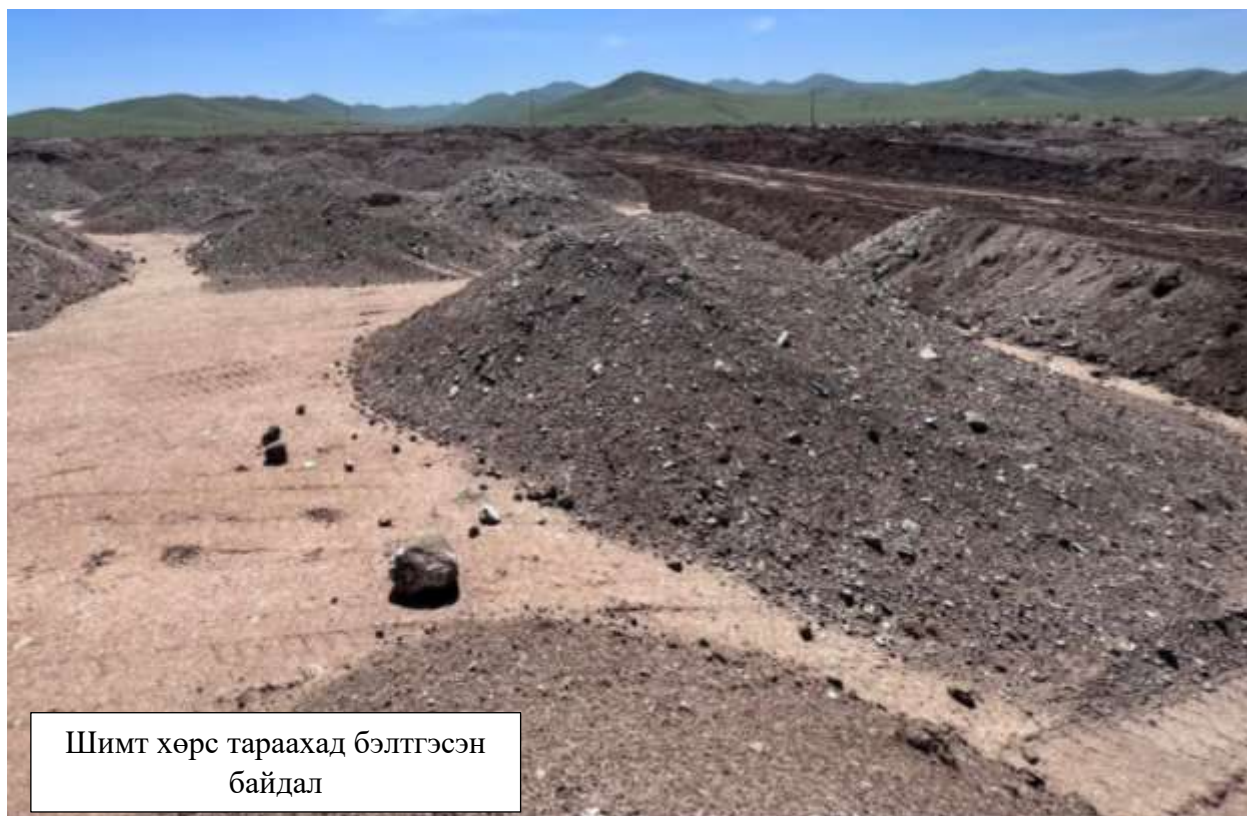
Зураг 22 Шимт хөрсний хучилтын ажил буюу Шимт хөрс дэвссэн байдал
