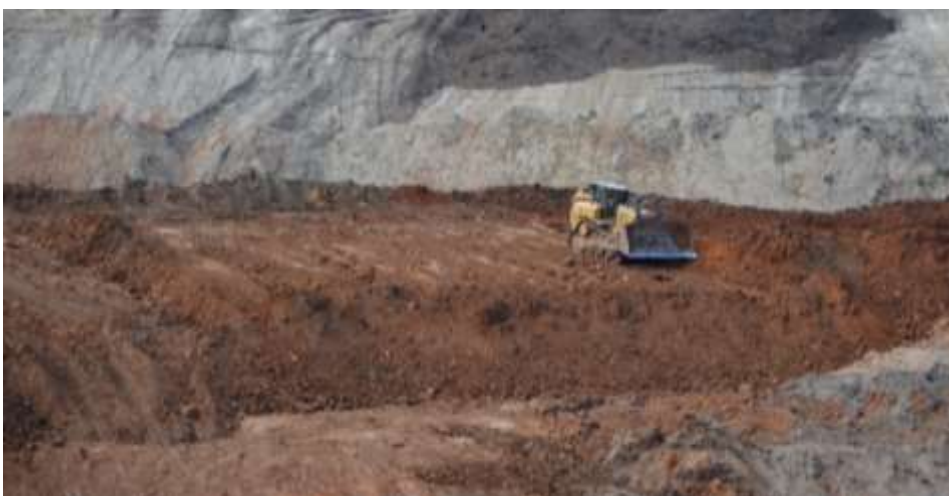
Зураг 21 Ухшийг дүүргэх, хурдас чулуулгийн овоолгыг намсгах, ирмэгийг налуулах, тэгшлэх, хэлбэршүүлэлтийн ажил явагдаж байна.
