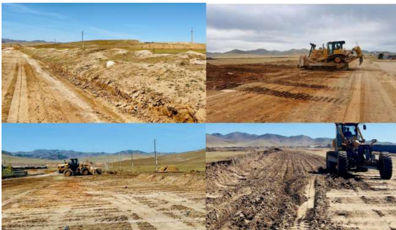
Зураг 26 Хуучин зам байсан талбайг түрж, шимт хөрсөөр хучсан. Хатуу хэсгийг Автогрейдерээр сийрүүлсэн
