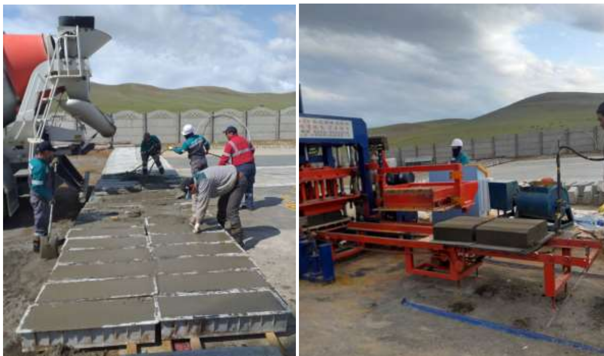
Зураг 5 Бетон боловсруулалтын явц
