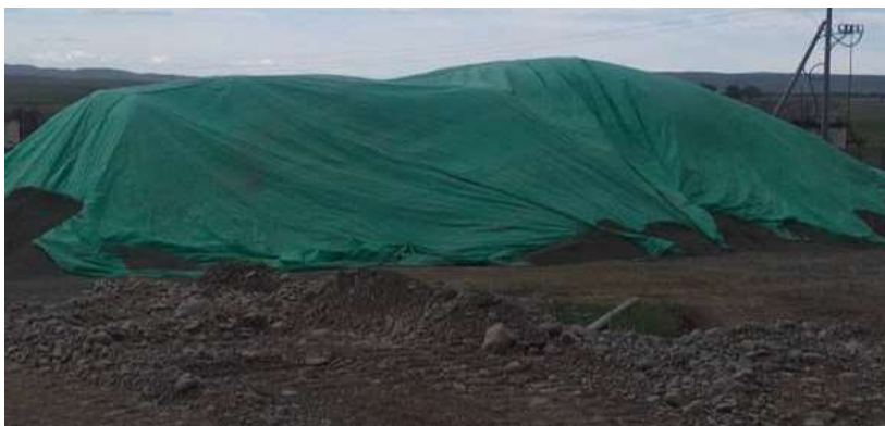
Зураг 11 Тоосжилтийг бууруулах зорилгоор хучилт хийж буй байдал
