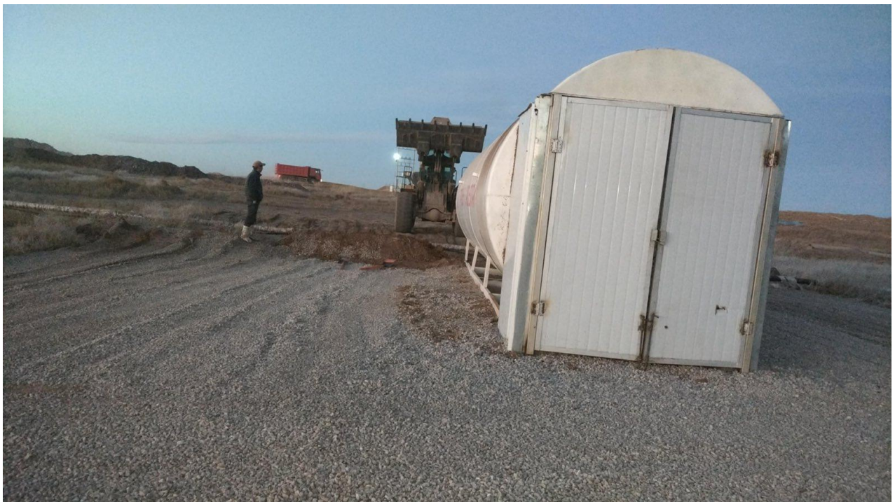
Зураг 8. Хөрсөнд асгаралт үүсэхээс сэргийлж хайрган хучилт хийсэн байдал
