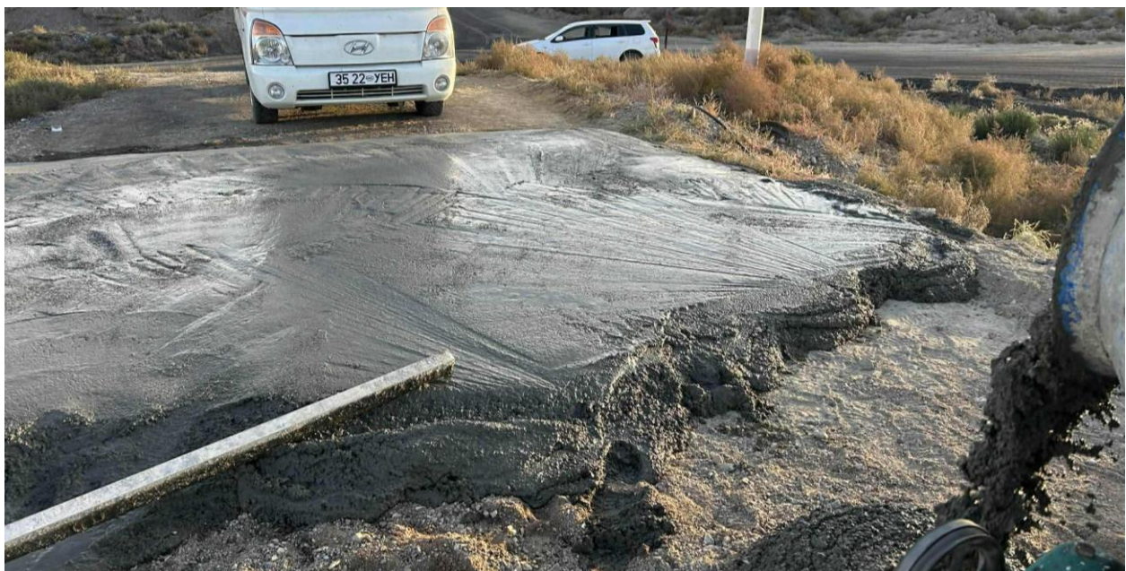
Зураг 13. ШТС-ын буулгах талбайг бетонон хучилт хийж байгаа нь
