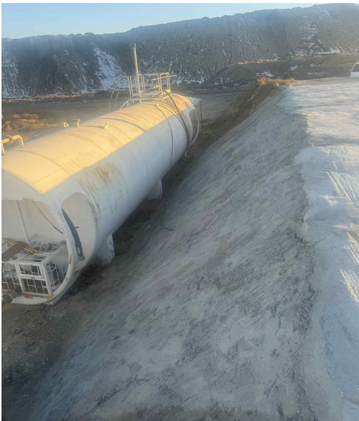
Зураг 14. ШТС-ын буулгах талбайн бетонон хучилт
