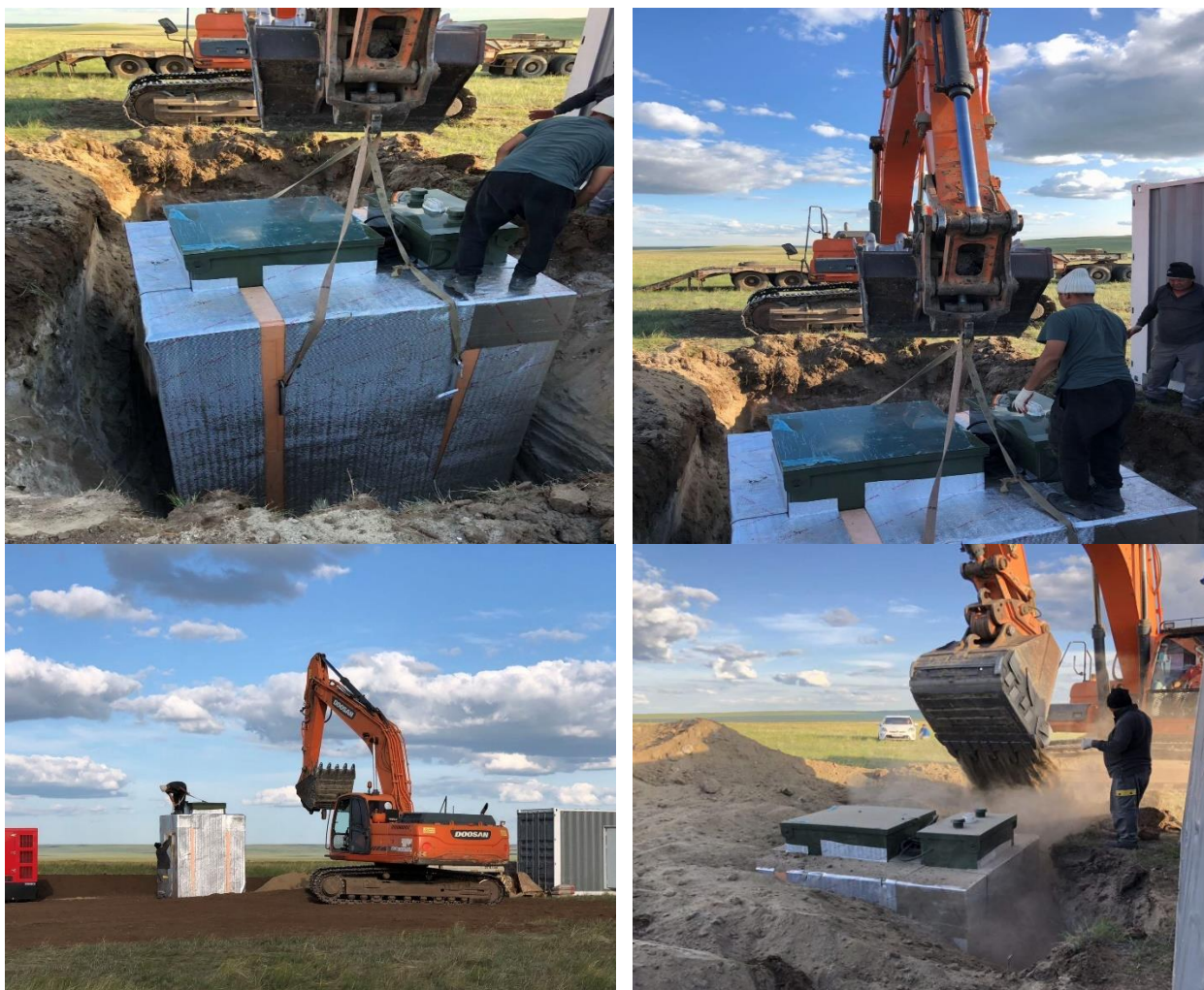
Зураг 8. Бага оврын цэвэрлэх байгууламж суурилуулж буй зураг
